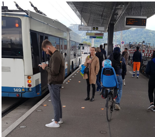
Abb. 16 LED-Leuchten am Boden für die Lenkung von Zufussgehenden und Velofahrenden im Bereich einer Tram-/Bushaltestelle
