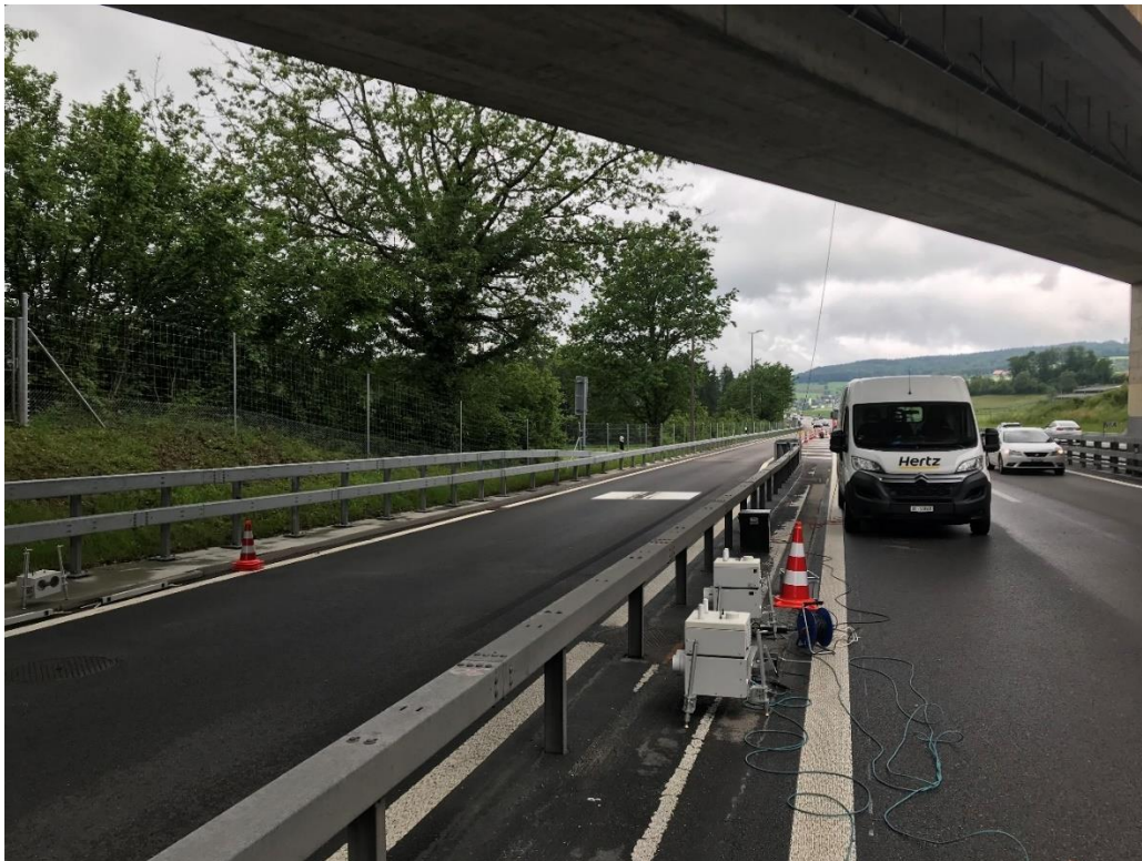
Abb. 8 Aufgebaute RSD 5500-Messgeräte von OPUS am Standort Knutwil (KNU). Der Lastwagenverkehr wurde über die in Fahrtrichtung rechte Warteraumspur geführt. Die reguläre rechte Fahrspur war abgesperrt für das Messtechnikerfahrzeug und die Messgeräte.
