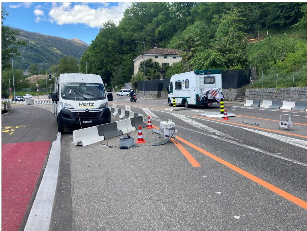
Abb. 18 Messungen mit dem Messsystem von OPUS am Standort Muzzano (MUZ) nahe Lugano. Der Standort erwies sich als ideal für die RES-Messungen, da aufgrund einer temporären Baustelleninstallation für Messgeräte und Messtechnikerfahrzeug genügend Platz vorhanden war.
