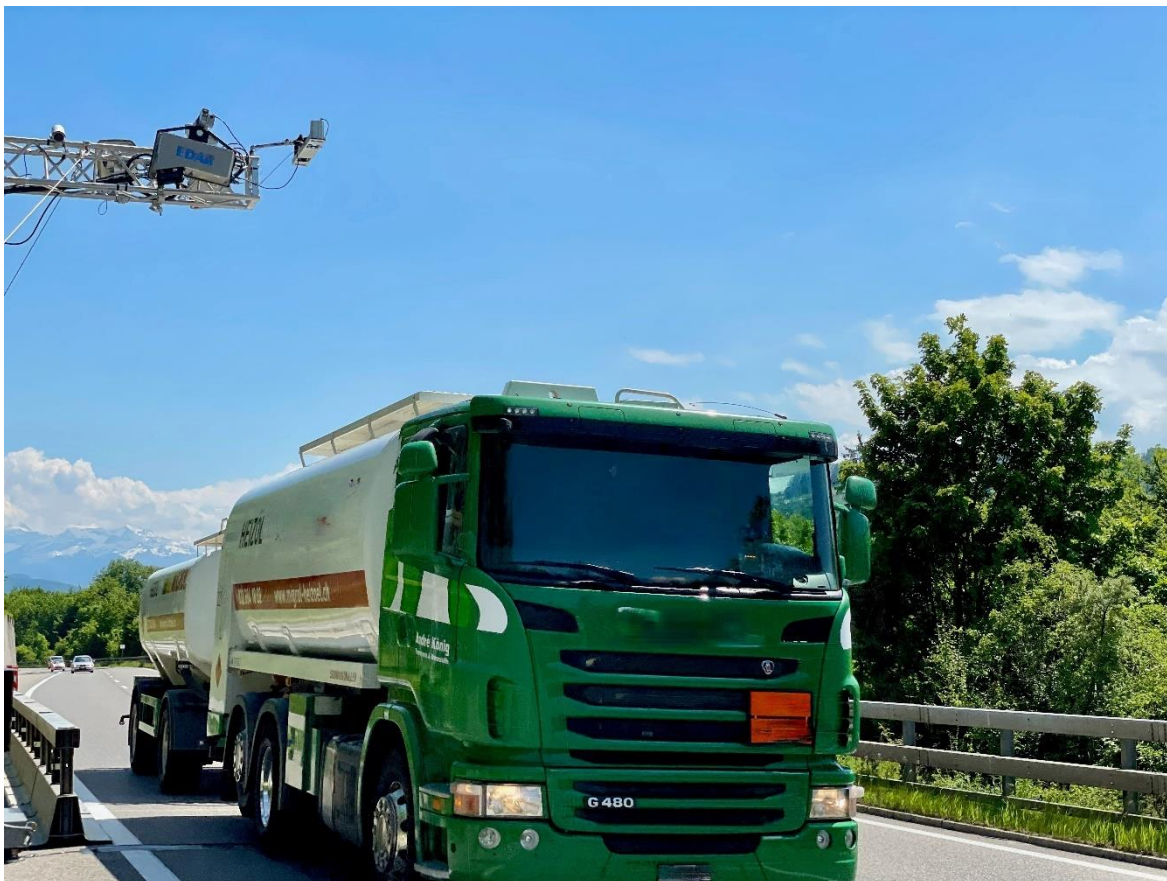
Abb. 6 Standort Rubigen (RUB) mit dem installierten EDAR 1 RES-Messsystem über der Fahrbahn. Auf der Fahrbahn ist der Reflektorstreifen sichtbar.
