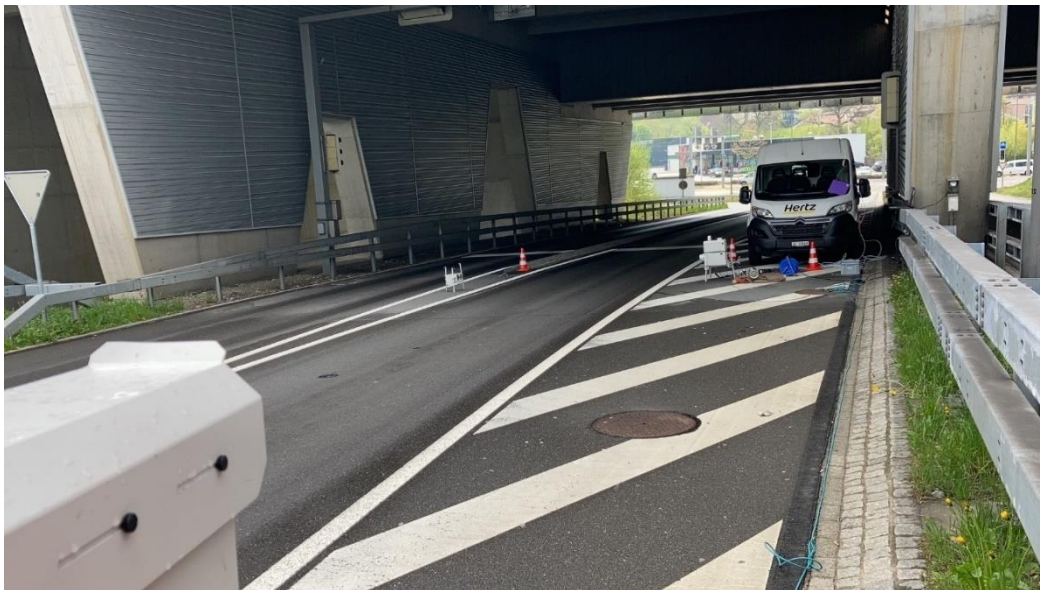
Abb. 15 Überblick zum Messstandort in Dierikon (DIR). Gemessen wurde an einem überdachten Standort unmittelbar vor der Einfahrt in den Autobahnzubringer-Tunnel Buchrain.
