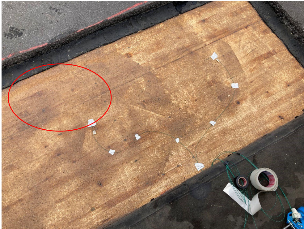
Abbildung 105: Einbau der Sensoren auf der ersten Schicht (besandete Epoxidharzgrundierung), Linker Fühler für dunkle Abstreuerung (T1), Rechter Fühler für helle Abstreuerung (T5)
