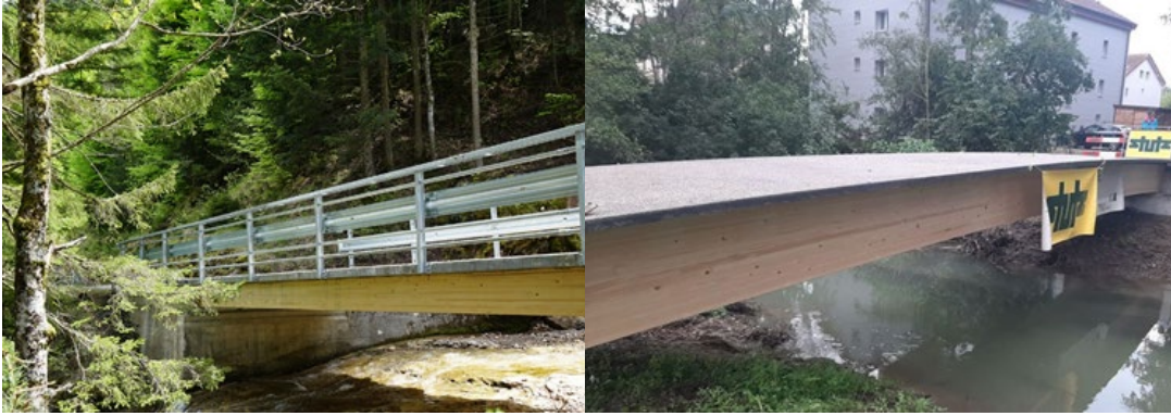
Abbildung 4: Neue Fruttlibrücke in Arth (SZ) links und der neue Fussgängersteg über die Sure in Oberwil (BL) (Quellen: Edgar Kälin und Hecht Holzbau AG)
