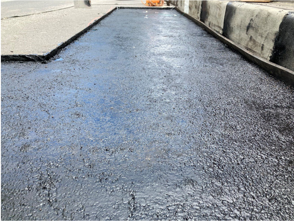
Abbildung 102: Eingebachte Asphaltenschutzschicht
