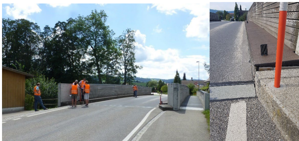
Abbildung 5 : Obermattbrücke (Lauperswil, BE) mit einem Detail des Randanschlusses und Fahrbahnübergangs
