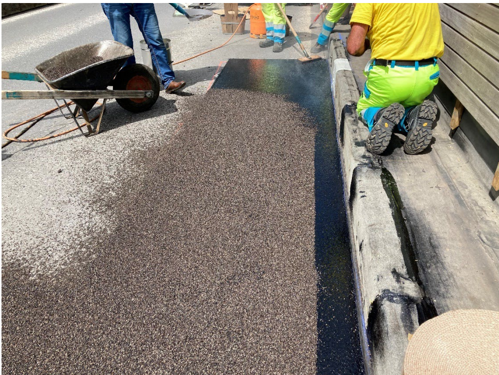
Abbildung 103: Eingebachte Asphaltdeckschicht mit dunkler Abstreifung
