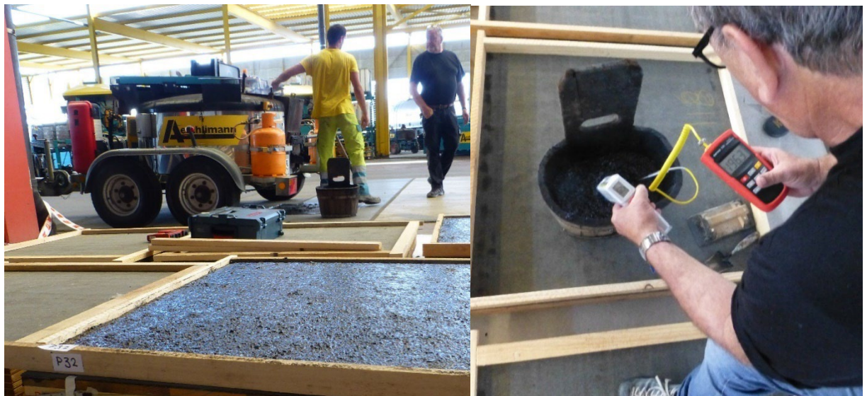
Abbildung 13: Aufwärmung des Asphalts im Kocher (links) und Messung der Temperatur in Holzkübel vor Applikation (rechts)
