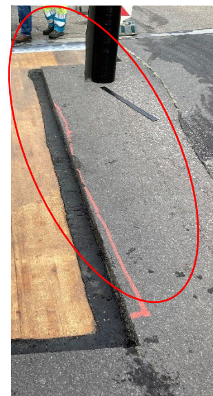
Abbildung 98: Neu beschichtete Holzunterkonstruktion mit besandeter Epoxidharzgrundierung, darunter verleimte und verschraubte Furnierschichtholz platten um die Tragfähigkeit der Unterkonstruktion wiederherzustellen
