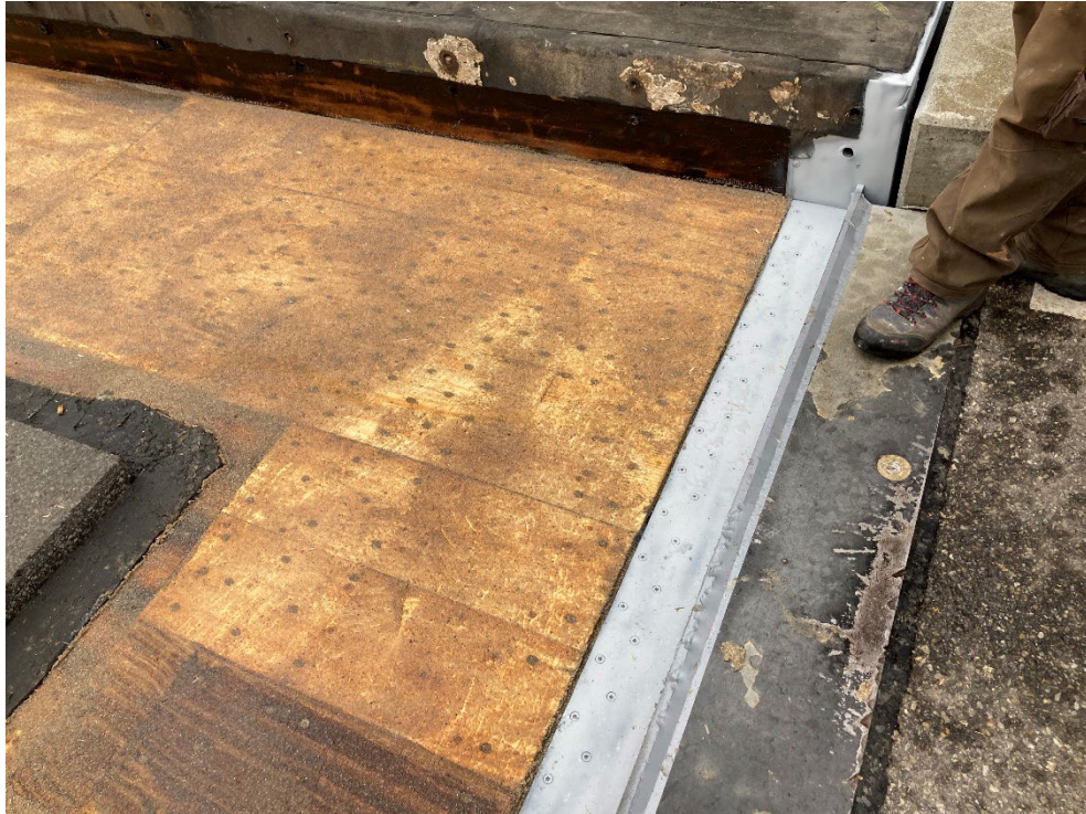
Abbildung 98: Neu beschichtete Holzunterkonstruktion mit besandeter Epoxidharzgrundierung, darunter verleimte und verschraubte Furnierschichtholz platten um die Tragfähigkeit der Unterkonstruktion wiederherzustellen
