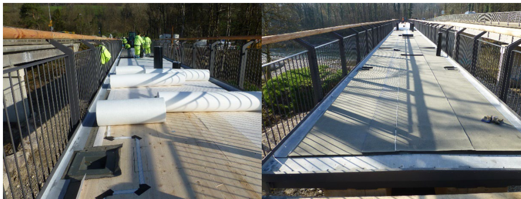
Abbildung 71: Sensorbänder «smartex dm» auf der Holzplatte während der Verlegung des Glasvlies und der PBD-Abdichtung (rechts) und nach der Verlegung (links)
