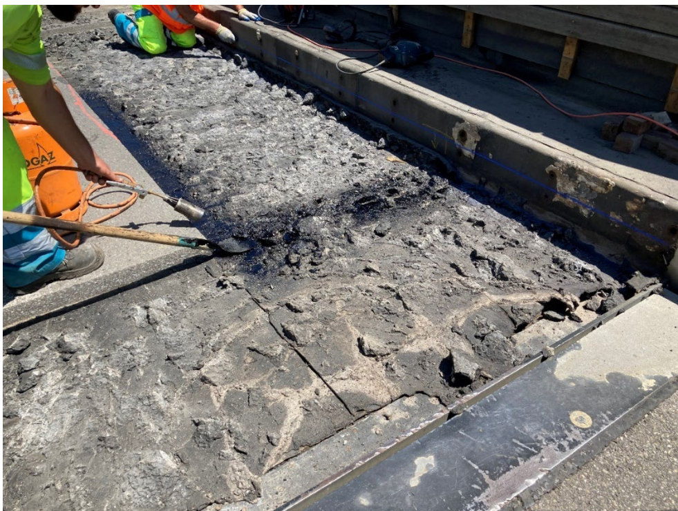
Abbildung 95: Ablösen des restlichen Asphaltes und der PBD von der besandeten Epoxidharzgrundierung mittels Brenner und Spatel/Kratzer
