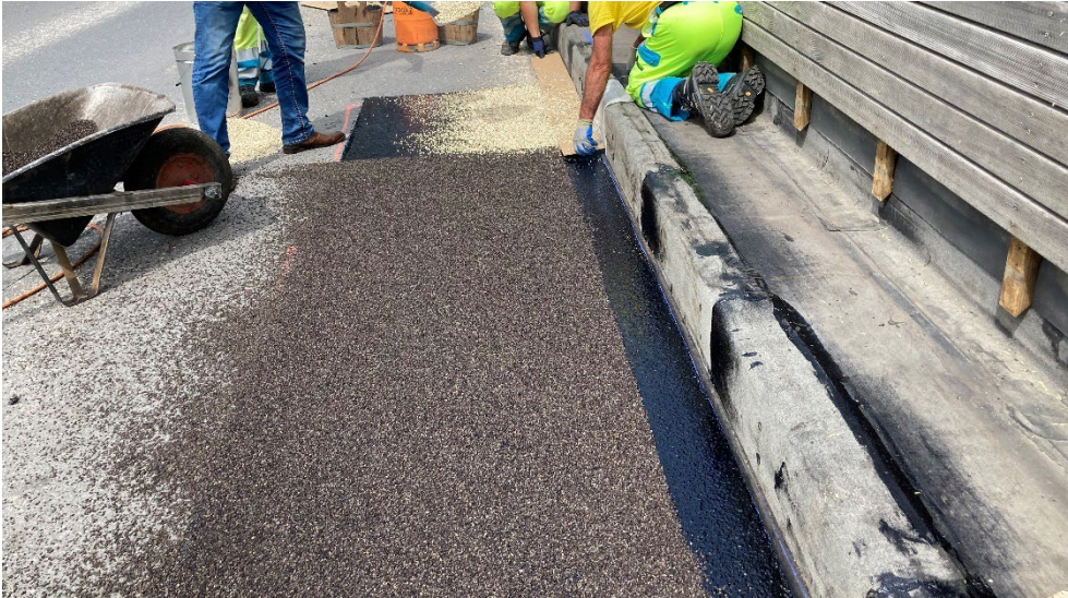
Abbildung 104: Eingebrachte Asphaltdeckschicht mit heller Abstreuung für Versuchszwecke
