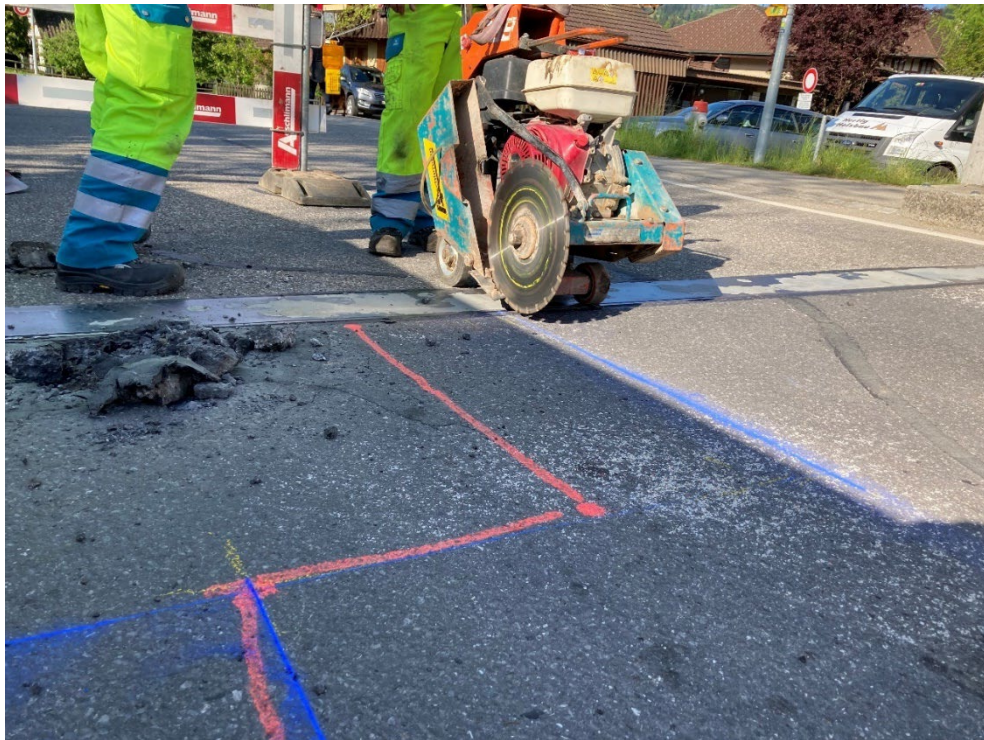
Abbildung 93: Einschneiden in den Asphalt bis einige mm über die darunterliegende Abdichtung
