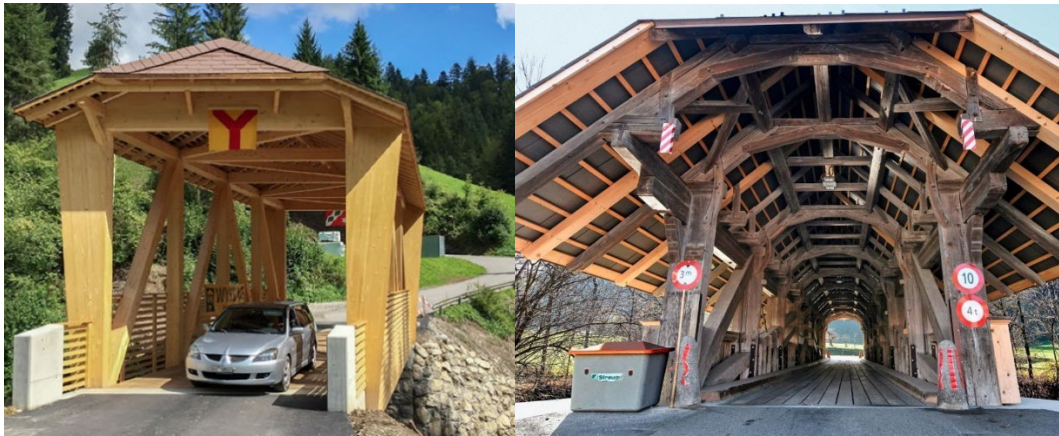
Abbildung 2: Beispiele von Brücken mit Holz als Fahrbahnbelag (Links ist die neue Wühribrücke (Quelle: timbatec.com ) und rechts die Ramserenbrücke abgebildet (Quelle: Thomas Peter, bernerzeitung.ch ))
