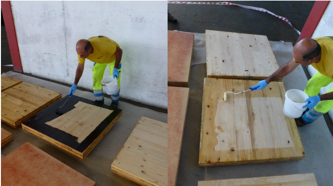
Abbildung 9 : Applikation von Elastocol 500 (links) und Primer RKH (rechts)
