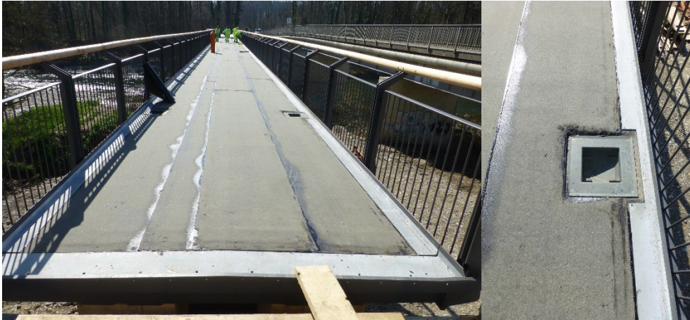
Abbildung 72: PBD-Abdichtung nach dem Verschweißen der Stösse und Abb. 70 die Situation bei den Einlaufschächten (rechts)
