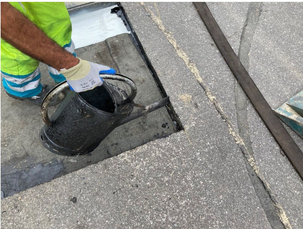
Abbildung 101: Bituminöser Randanschluss
