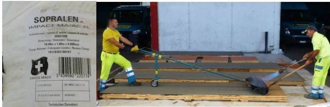
Abbildung 12: Das Applizieren der PBD-Bahnen auf die Epoxidharzversiegelungen mit Flamme und Gliederwalze zur Verteilung der Anpresskraft
