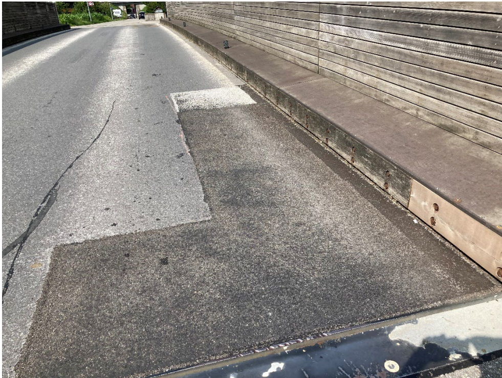
Abbildung 110: Sanierter Fahrbahnbelag ca. 30 Tage nach Einbau
