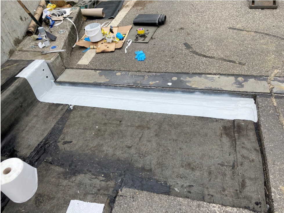
Abbildung 100: FLK (Flüssigkunststoff) Abdichtung mit eingelegtem Armierungsgewebe
