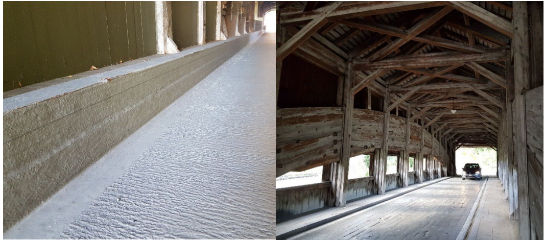
Abbildung 3 : Bilder der Direktbeschichtungen mit PMMA und Bitumen in der historischen Thurbrücke in Andelfingen (ZH) links und Schüpbachbrücke in Schüpbach (BE) rechts
