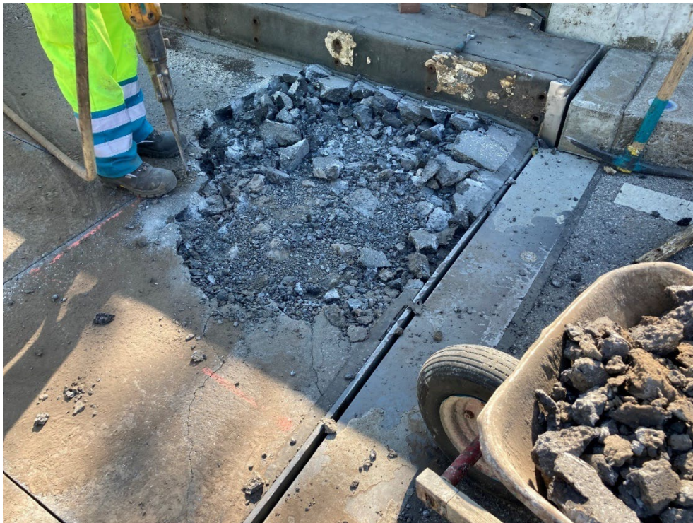
Abbildung 94: Ausbrechen des Asphaltes im Schubverbund mittel Presslufthammer
