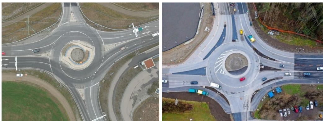
Fig. 13 Glättimüli (relevé par drone – RGR, 2020), Heimberg ( Berner Zeitung , 2019).
