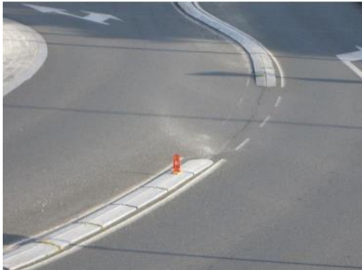
Fig. 9 Non-continuité des séparateurs de voies afin de garantir l'entretien hivernal, Slovénie [52].
