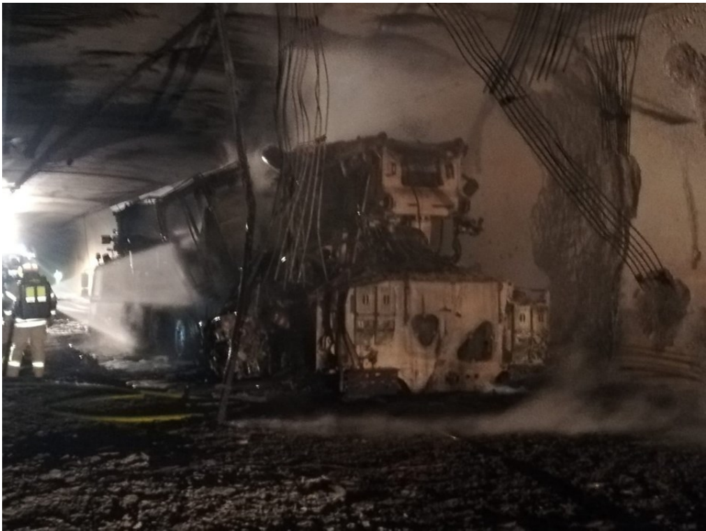
Abb. 10 Situation im Tunnel nach Brand eines Schwerlasttransporters
