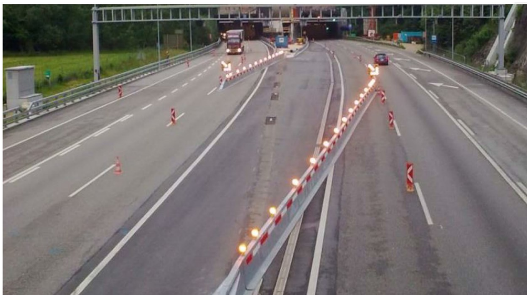
Abb. 13 Beispiel einer Mittelstreifenüberfahrt
