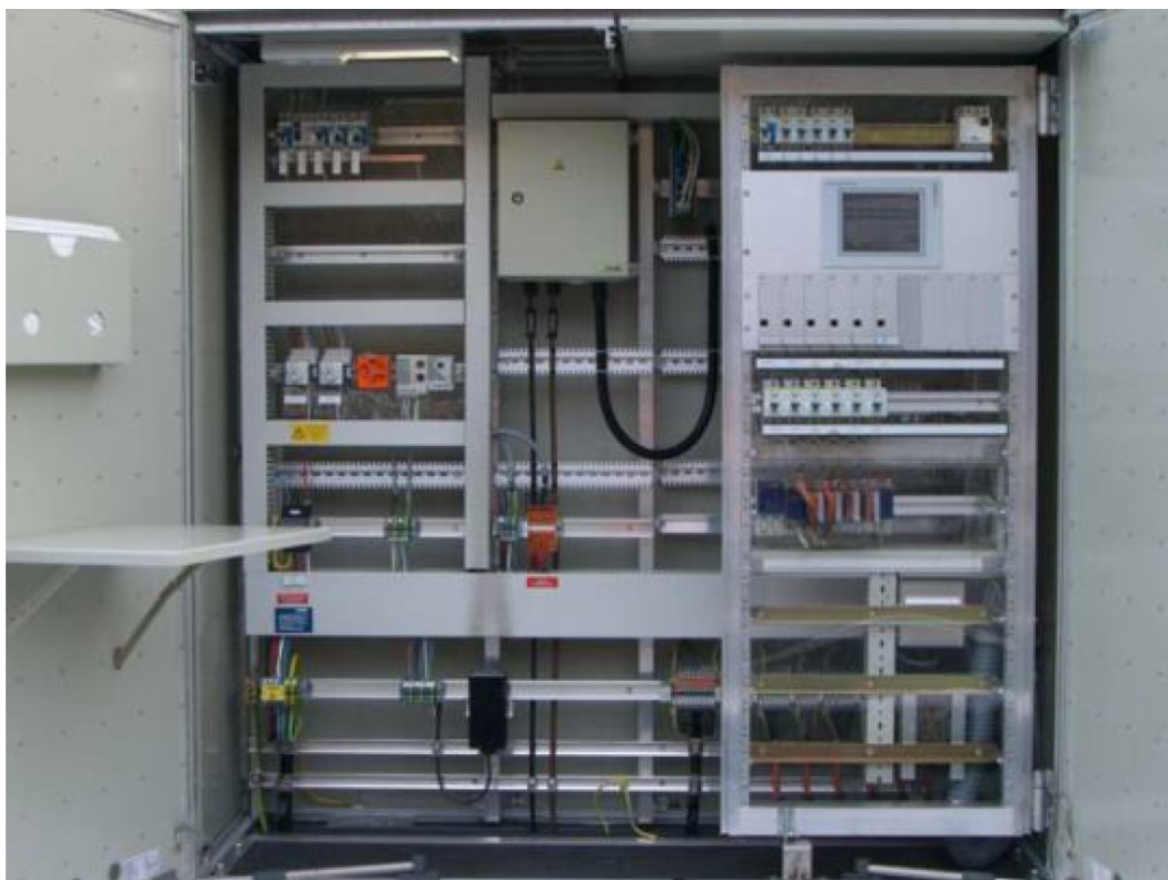
Abb. 11 Möglicher Ausbau einer Lokalsteuerung inkl. Möglichkeit zur Vorortbedienung
