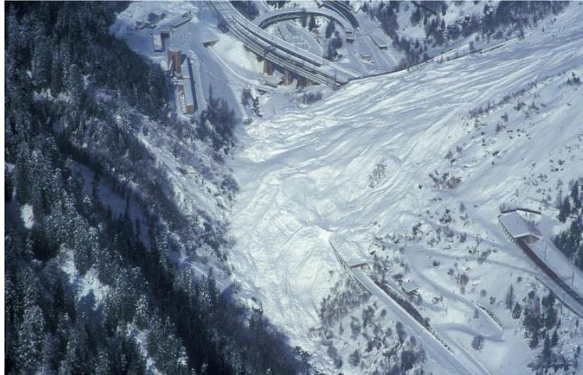
**Abb. 2** Die Galerie „Rotlouwi“ im Februar 1999. Die Mächtigkeit der Ablagerung auf dem Galeriedach beträgt mehr als 15m (Foto: S. Margreth, SLF).
