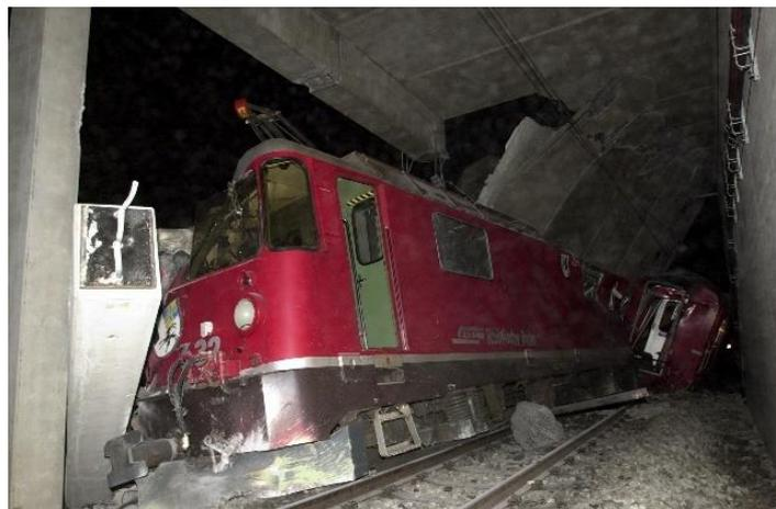
**Abb. 5** Lawingalerie der Rhätischen Bahn in der Rheinschlucht nach einem Versagen aufgrund Stützenanprall (Galerie Valendas). Die Lokomotive war wegen eines Schuttkegels unmittelbar vor der Galerie entgleist und zerstörte vier Pfeiler. (Foto: Kantonspolizei Graubünden, 5.1.2007).
