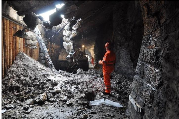
**Abb. 4** Lawingalerie an der Samnaunerstrasse nach einem Versagen aufgrund einer beinahe vertikal auf das Dach gefallenen Lawine (Bild: S. Margreth, 9.4.2009).
