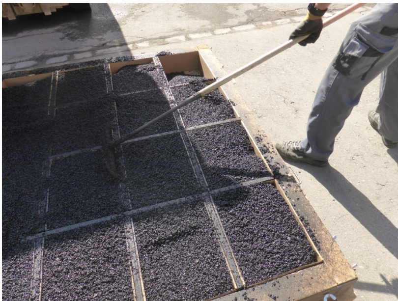
Abb.4 Mischgutentnahme mit Rahmen-Schachtel-System
