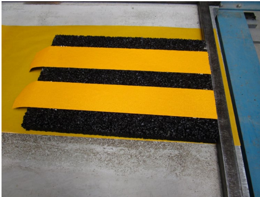
Abb.25 Aufbringen der Markierungstreifen 3M Scotch-Lane A651
