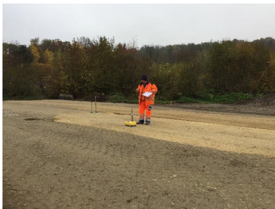
Abb.4 Überprüfung der Verdichtung mit der Isotopsonde
