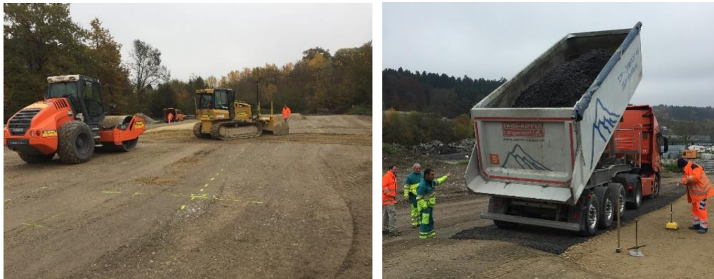
Abb.2 rechts: Ablad zweite Schicht – links: Planieren der zweiten Schicht
