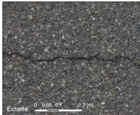
Une fissure dans une orthophoto générée à une résolution de 1 mm par le système ARRPA.
