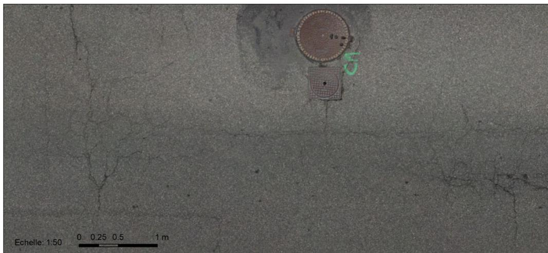
**Figure 40** : Charles-Naine, état 0 (30.05.2018) : faïençage, fissures longitudinales et transversales, visibles dans l'orthophoto
