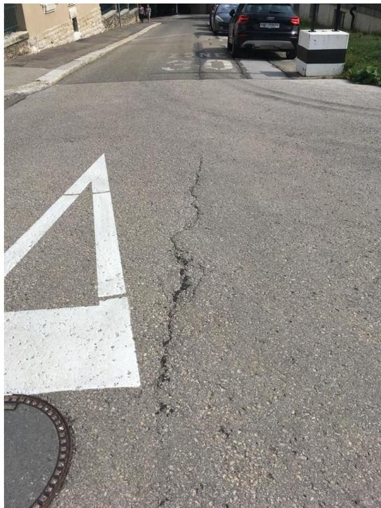
**Figure 83** : Stavay-Mollondin, relevé détaillé (27.08.2019) : Fissure ouverte et profonde à ponter
