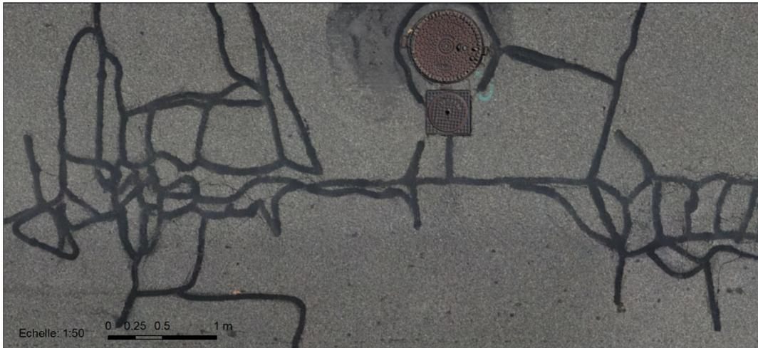
**Figure 43** : Charles-Naine, état intermédiaire 0.5 (12.10.2018) : fissures et faïençages colmatés à la lance thermique
