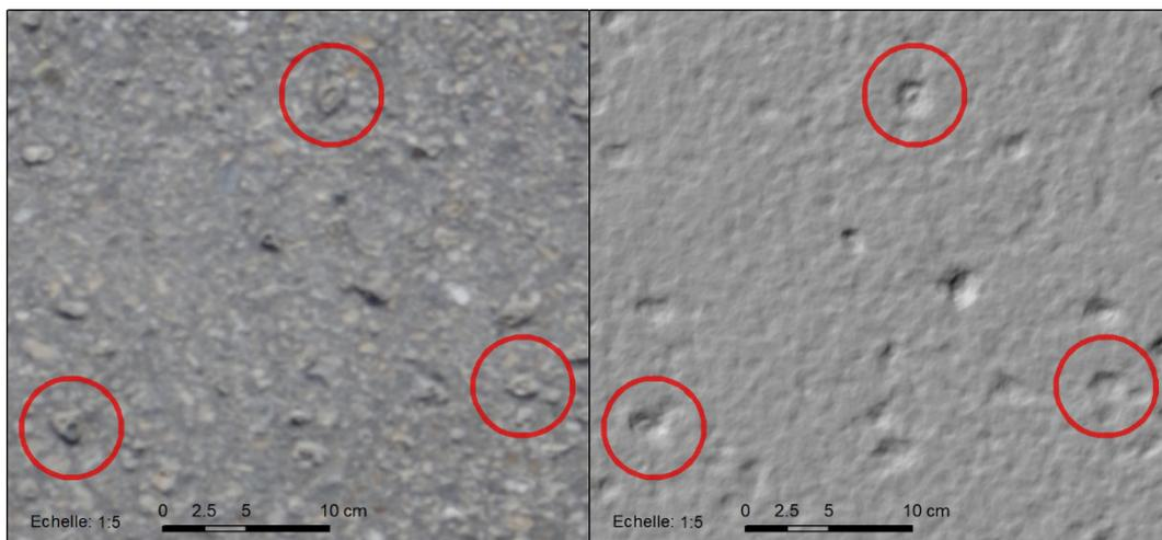
**Figure 62** : Commerce, état 1, 29.03.2019 : trous de gravillons détachés colmatés par des granulats
