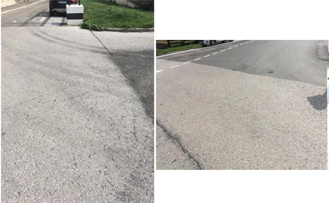
**Figure 82** : Stavay-Mollondin, relevé détaillé (27.08.2019) : gros grains qui partent de gravité modérée
