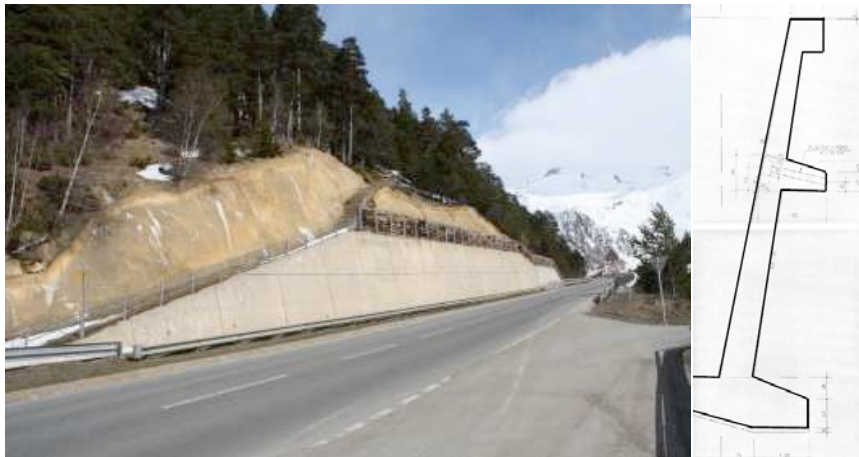
Abb.35 Ansicht und Querschnitt der Stützmauer an der Simplonpassstrasse. Die Stützmauer ist nach Süden ausgerichtet.
