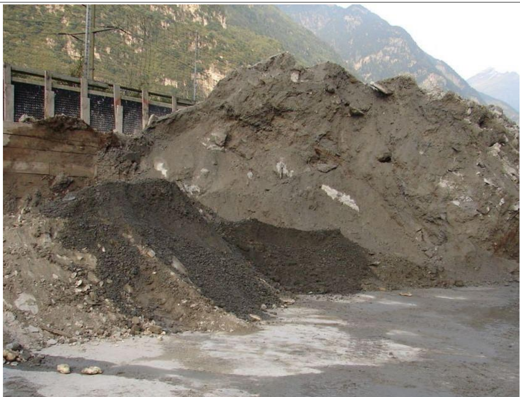
Abb.13 Rückstände: Rückprall, Abbruchmaterial, Sohlreinigung
