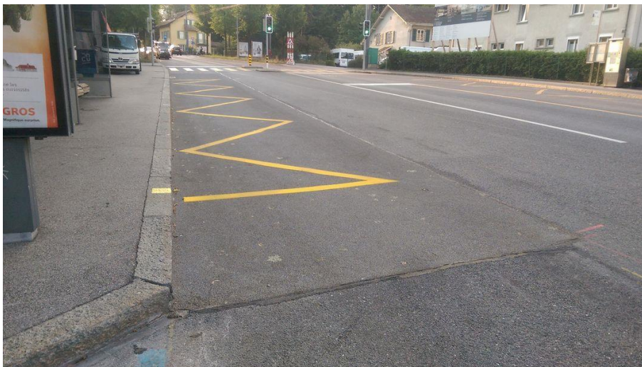
Fig. 21 Chaussée de l'arrêt de bus Foyer après réfection
