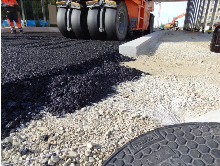
Fig. 14 Pose de la couche bitumineuse en ACT 32 avec vue sur la chambre d'arrivée des câbles des capteurs DMS
