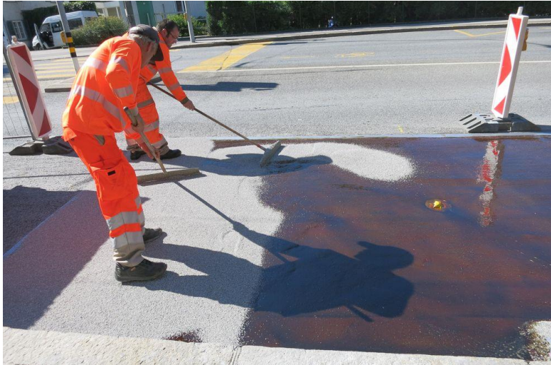
Fig. 20 Gravillonnage de la surface après pose du primer de la résine époxy
