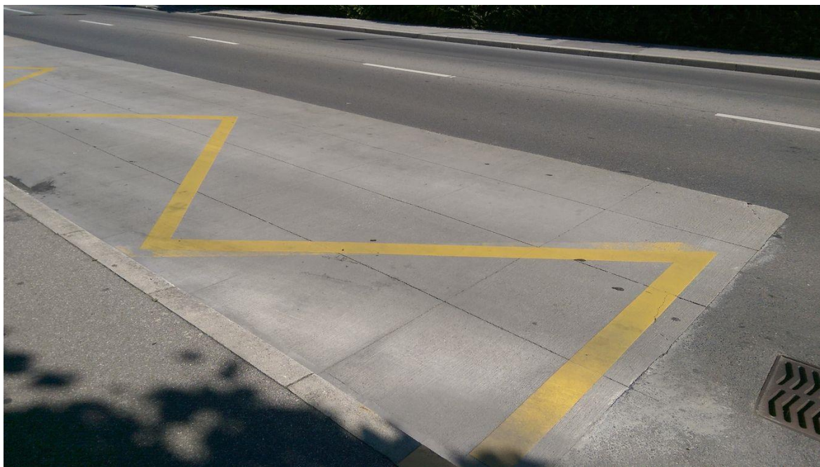
Fig. 9 Exemple d'arrêt de bus avec couche de roulement en béton de ciment mince collé
