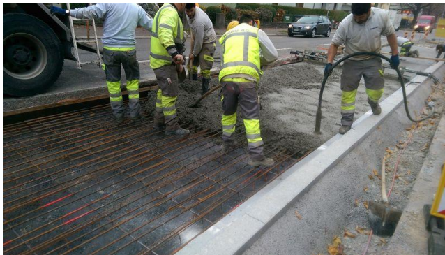
Fig. 27 Pose de la couche en béton armé continu avec mise en place par vibration du béton
