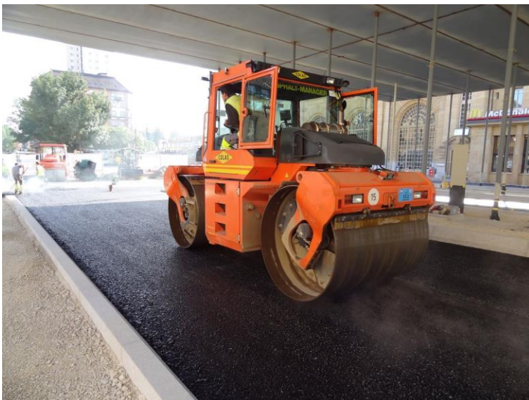
Fig. 15 Compactage de la couche en ACT 32
