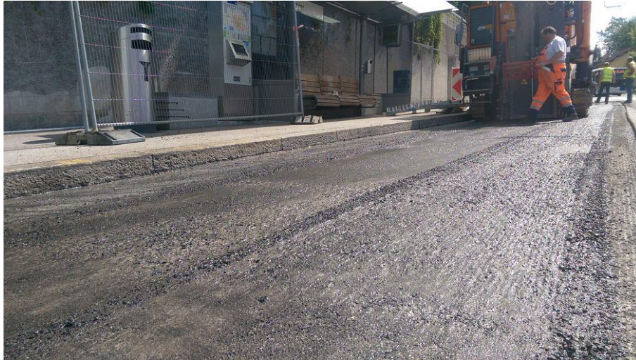
Fig. 19 Aspect de surface au sommet de la couche en AC EME 22 C1 après le micro-fraisage
