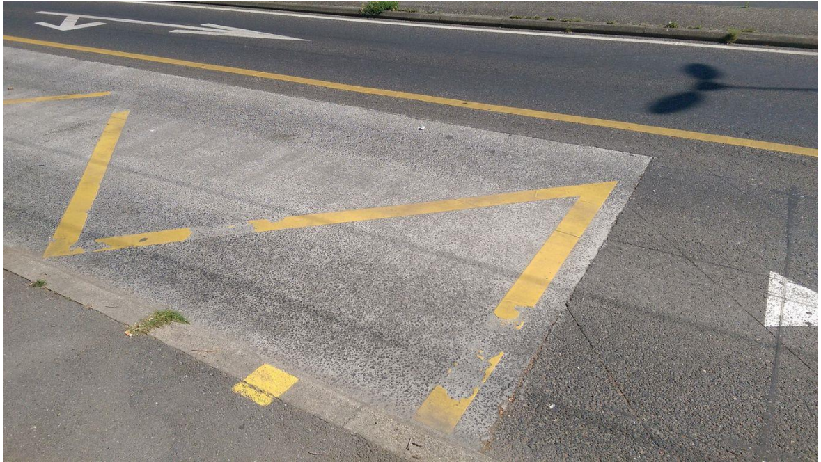
Fig. 7 Exemple d'arrêt de bus avec couche de roulement en enrobé percolé
