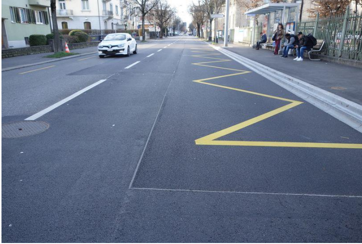
Fig. 28 Chaussée de l'arrêt de bus SBB – Werkstätte après réfection
