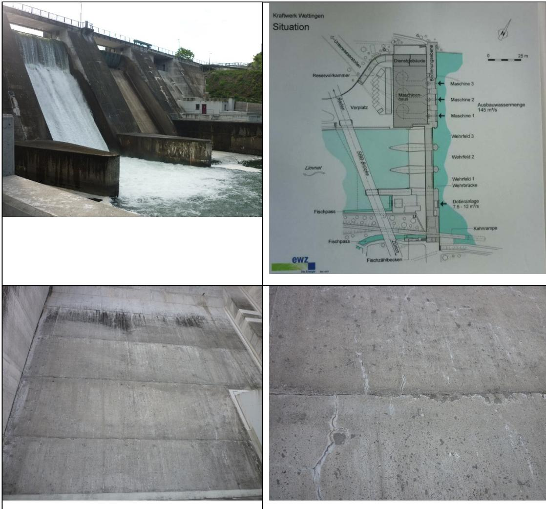
**Baujahr:** 1930-33, etappenweiser Umbau der Wehrfelder **2005 – 2007**. Beim 4. Wehrfeld (neue Dotieranlage) wurde 5 cm Beton abgetragen und 15 cm SCC aufbetoniert.
