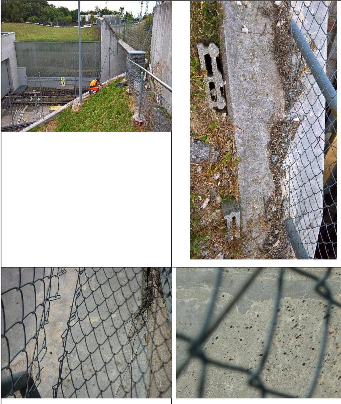
**Beschreibung:** Der Beton des Portals der Zufahrtsgalerie und der Stützmauern entlang den Gleisen zu den technischen Ateliers der Metro weisen ein feinmaschiges Rissnetz und Ausblühungen auf, das die dünnere Zementschlämme auf der Betonoberfläche durchschlägt. Die Zementschlämme ist bereichsweise abgelöst. Die Betonoberfläche ist abgewittert und zeigt einen geringfügigen Moosbewuchs.
