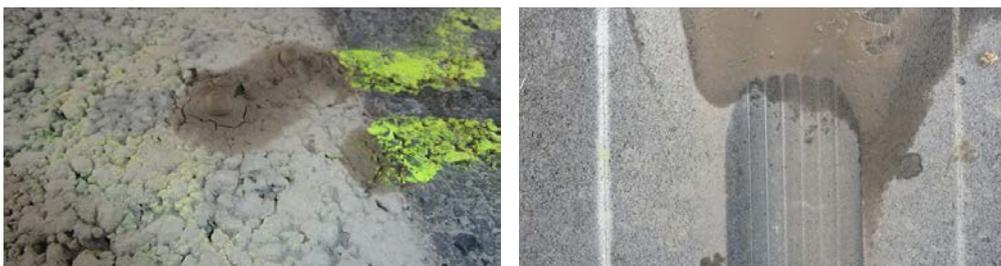
Abb. 39 Von Pumping-Effekt ausgeschwemmte Fundation im Bereich der Spurrinnen
