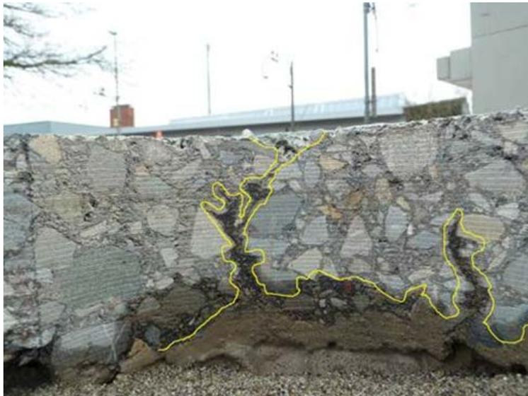
**Abb. 41** Bohrkernaussparung mit hervorgehobenen Bottom-Up-Rissen im belasteten Bereich von Testfeld 1. Im Bild ist der durch den Pumping-Effek verursachte Transport der herausgelösten Feinanteile aus Fundationsschicht zur Oberfläche ersichtlich
