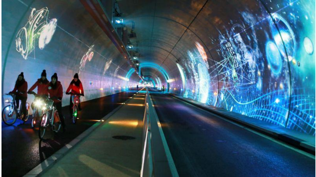
Fig. 34 Exemple d'aménagement souterrain : tunnel modes doux de la Croix Rouse (Lyon). Agrément positif
