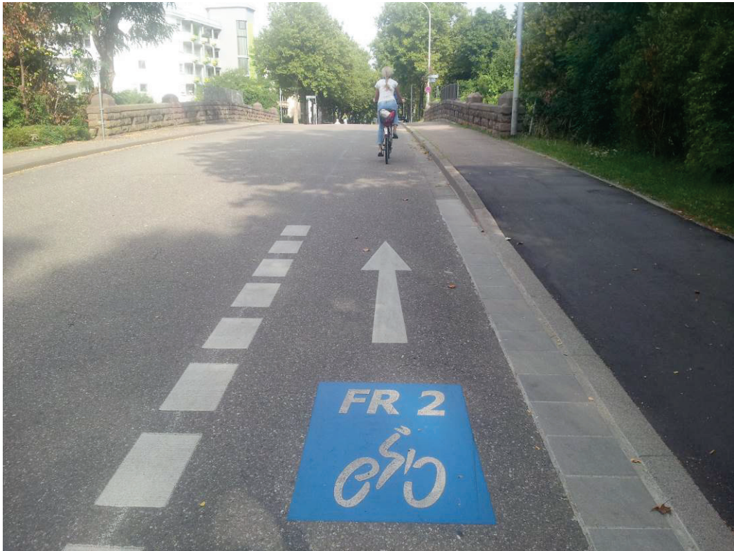
Abb. 22 Breiter Radstreifen (2.0 m breit) auf der Veloschnellroute FR2 im städtischen Quartier in Freiburg im Breisgau (D); Foto: Steffen Ries, Innovation Academy
