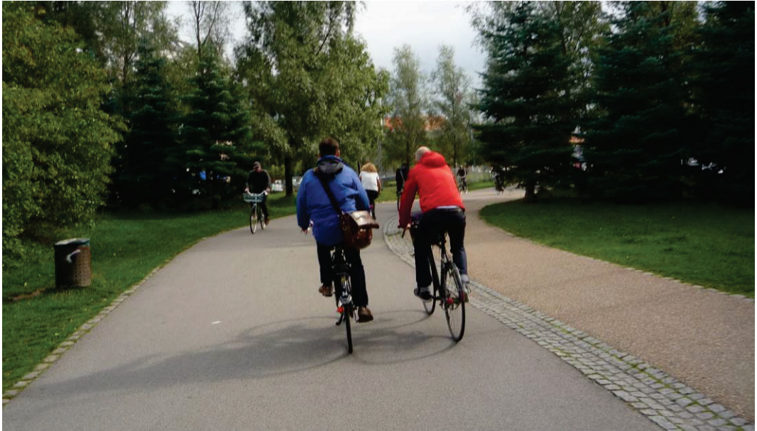
Abb. 12 Eigenständig geführter Zweirichtungsradweg (4 m breit) auf der „Nørrebro Route“ im städtischen Raum in Kopenhagen (DK)
