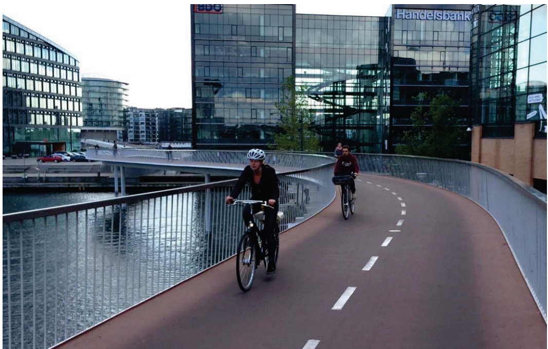
Abb. 13 Zweirichtungsradweg (4.25 m breit) auf einer Brücke auf der „Sø ruten“ im städtischen Raum in Kopenhagen (DK)
