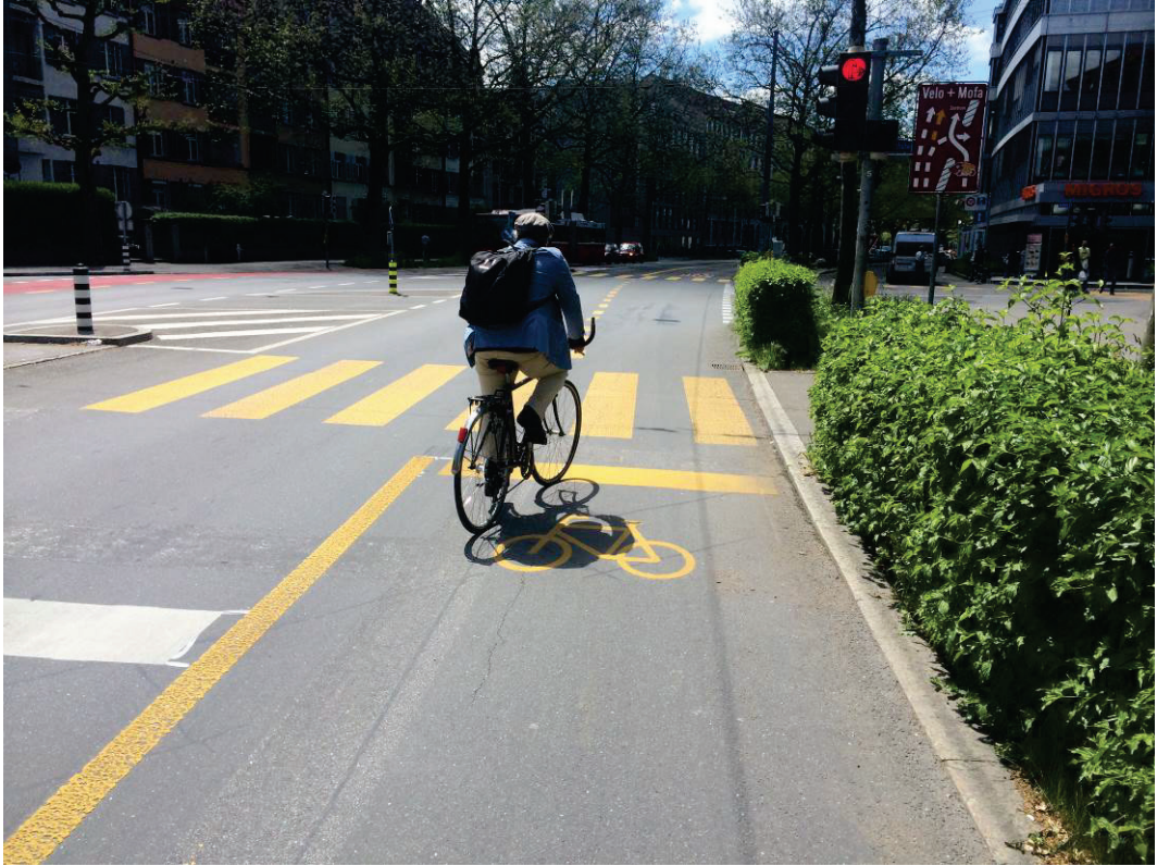
Abb. 51 Vorgezogener Haltebalken mit zuführendem breitem Radstreifen (ca. 2.5 m breit) auf der „Velohauptroute“ Wankdorf, Bern (CH)
