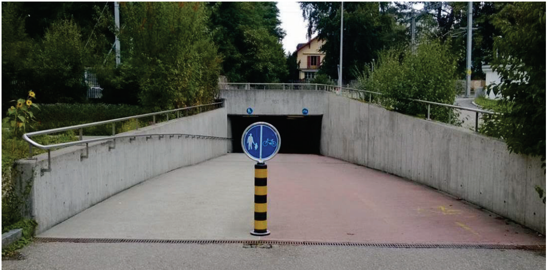
Abb. 39 Fussgänger- und Velounterführung beim Westbahnhof Solothurn (CH)
