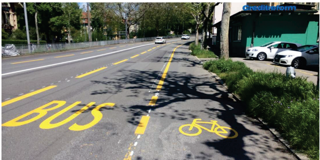
Abb. 35 Busstreifen mit breitem Radstreifen (2.50 m), Nordring Bern (CH)
