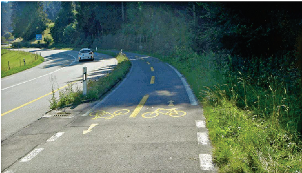
Abb. 55 Gezielter Einsatz von Markierung dort, wo notwendig, Beispiel Anlage Heimberg – Thun (CH)
