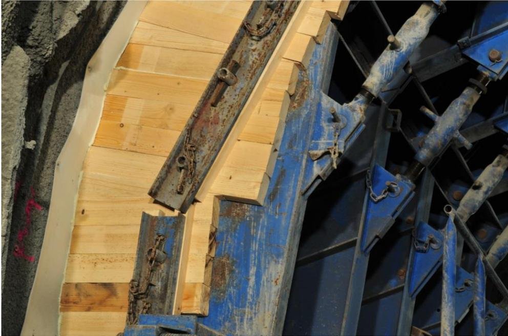
**Abb. 27** Stirnschalung mit Dichtungsschaum
