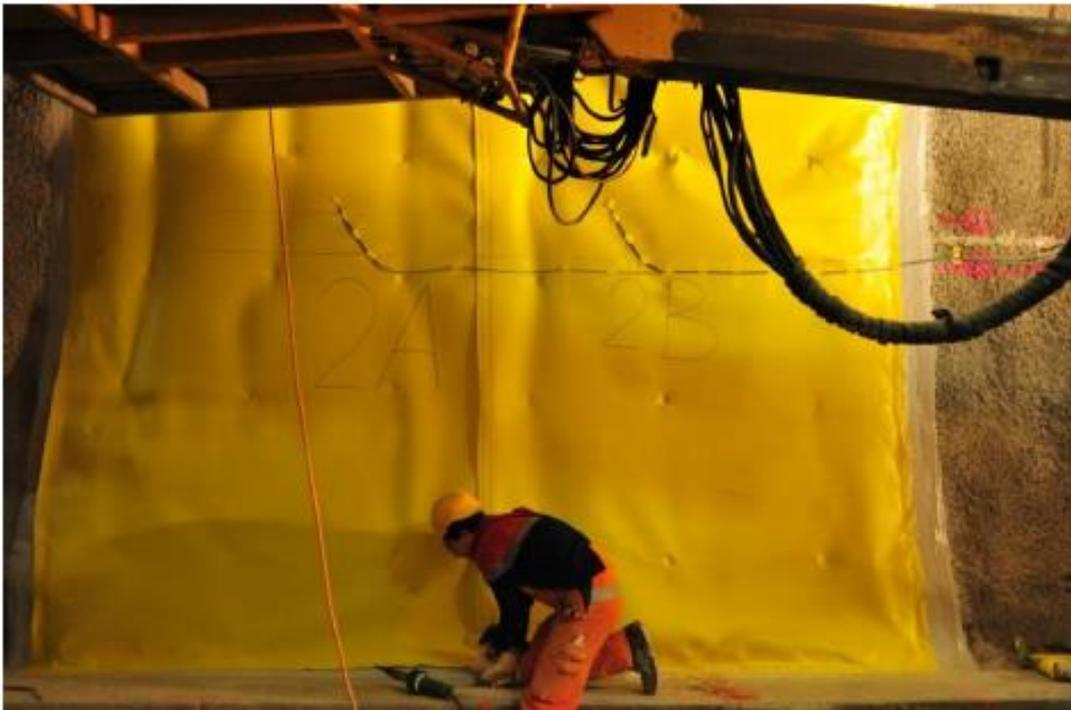
Abbildung 11 Versuchsfeld 2, Montage Abdichtungsfolie
