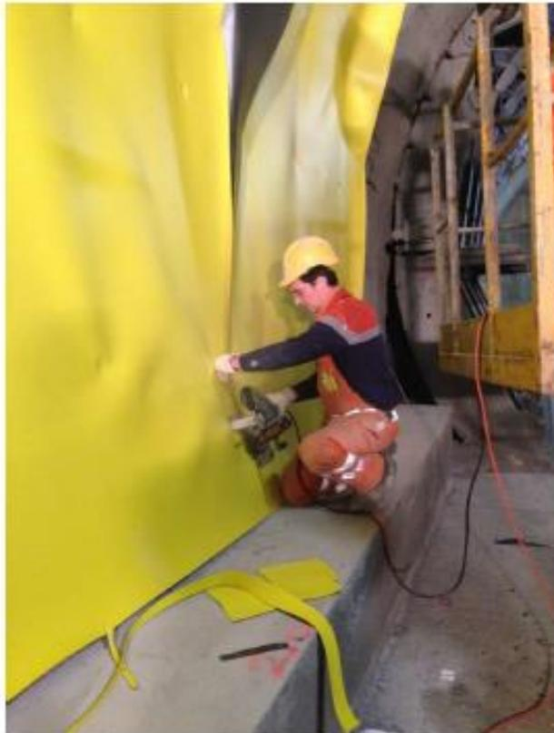
Abbildung 16 Montage Abdichtungsfolie
