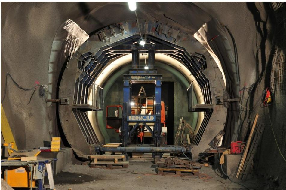
**Abb. 24** Platzieren der Gewölbeshalung im Versuchsbereich
