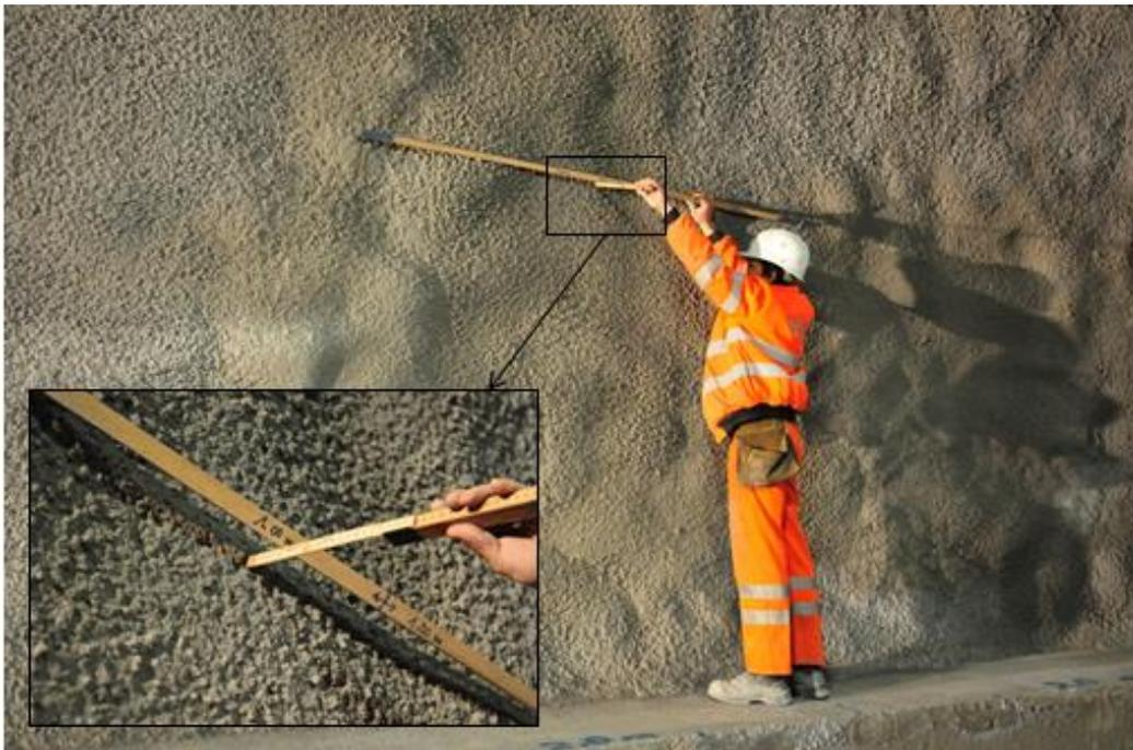
**Abb. 17** Überprüfung der Ebenheit der Oberfläche
