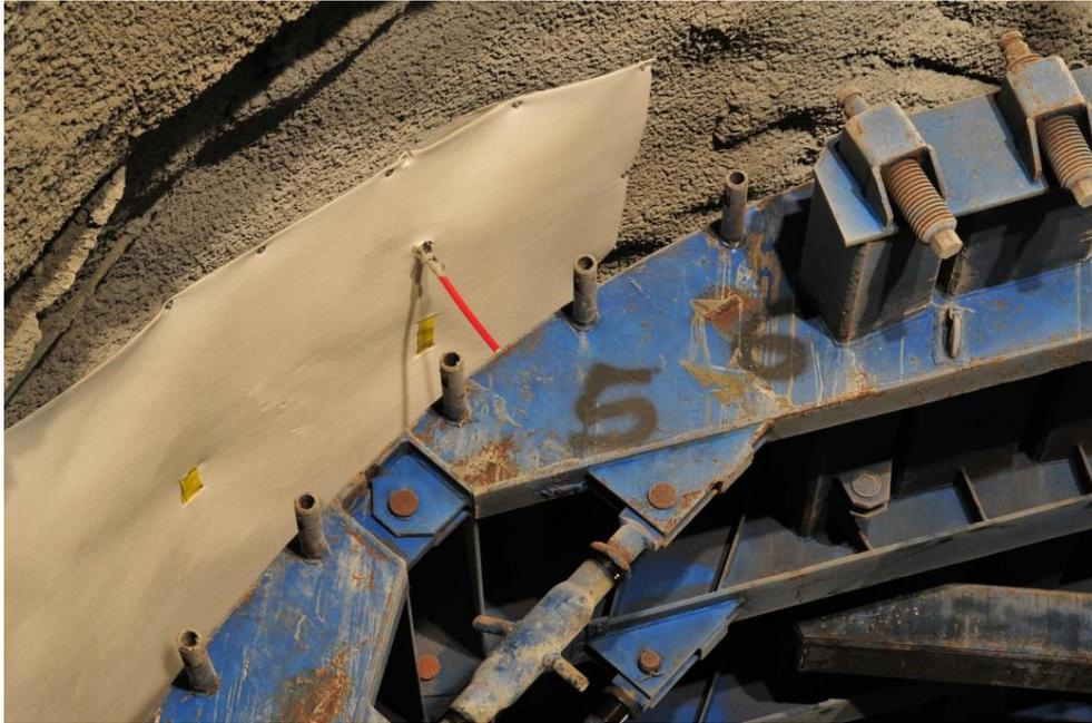
**Abb. 25** Gewölbeschalung und Absorberanschlussleitung
