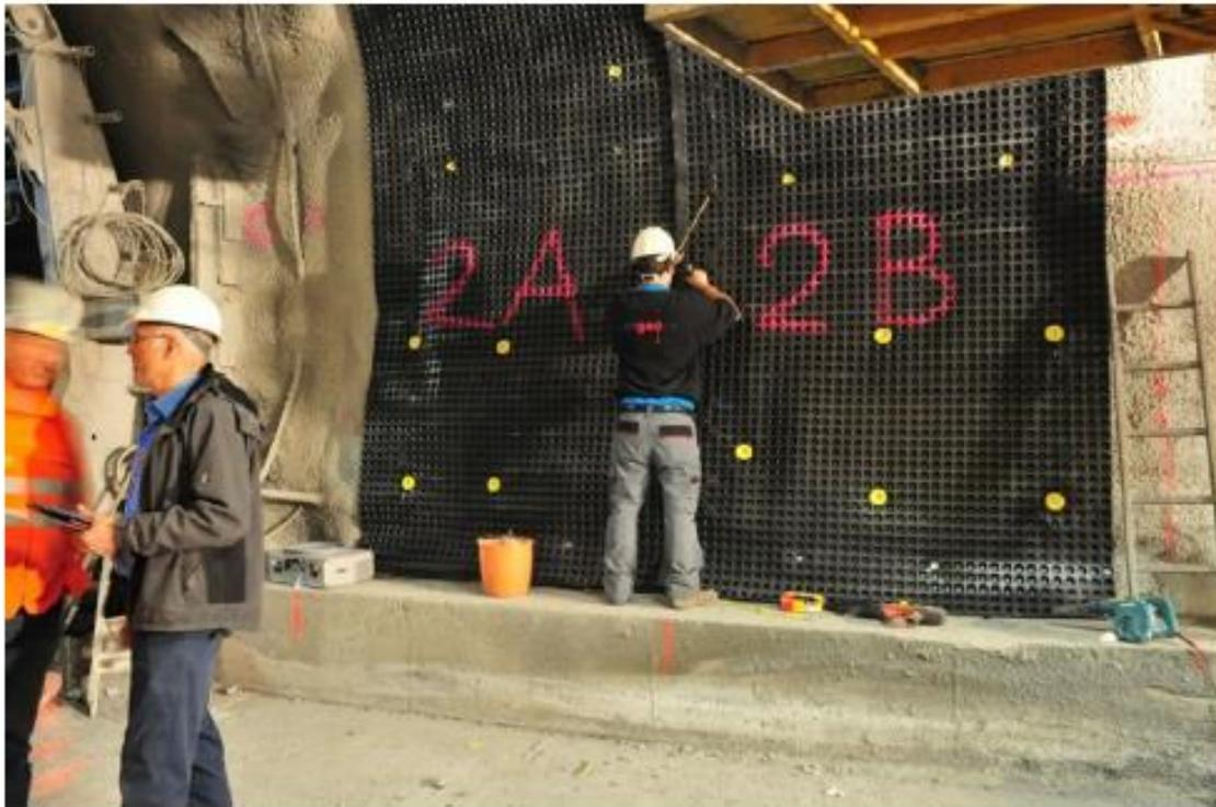
Abbildung 7 Versuchsfeld 2, Montage Absorbermodule
