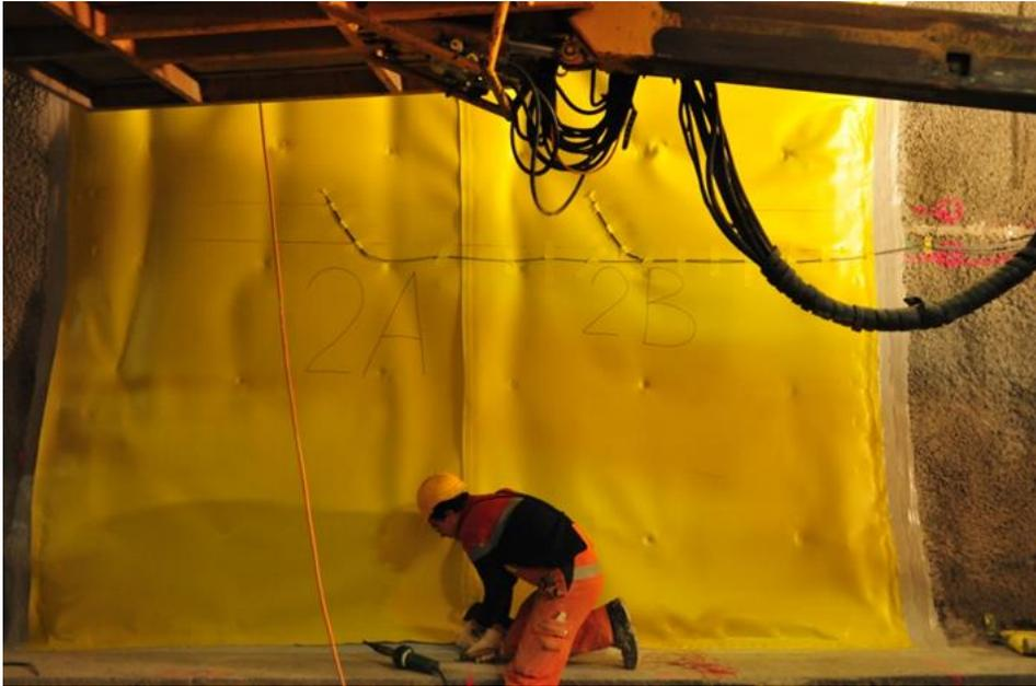
**Abb. 23** Sensorkabel der Temperaturmessfühler im Versuchsfeld 2
