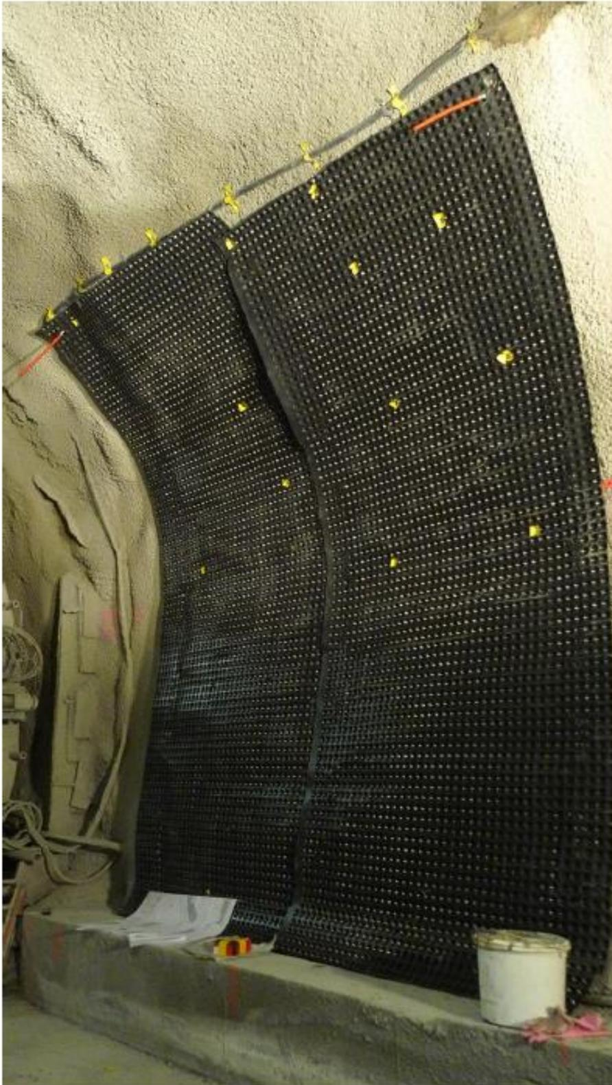
Abbildung 9 Versuchsfeld 2, Module montiert
