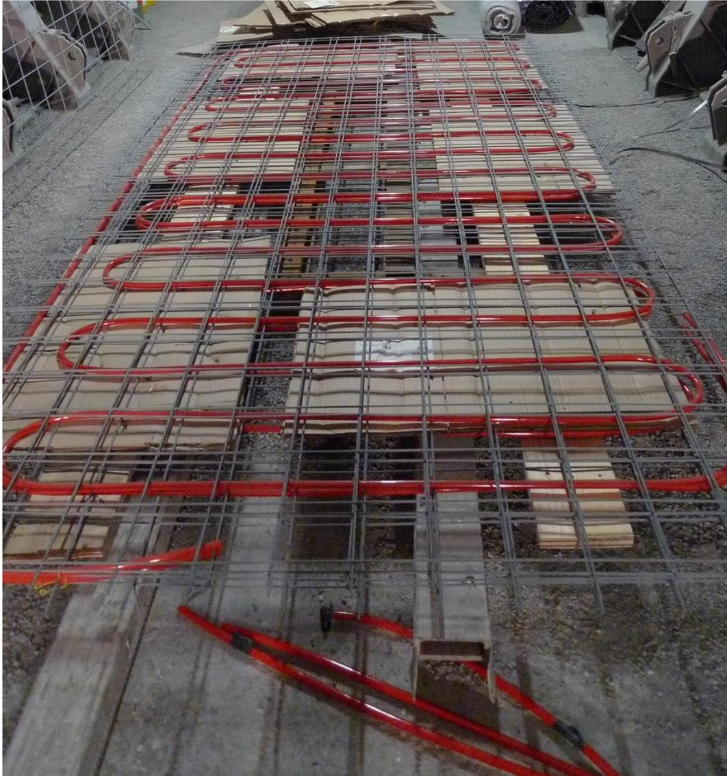
**Abb. 52** Foto Absorbermodul Typ Bewehrungsnetz
