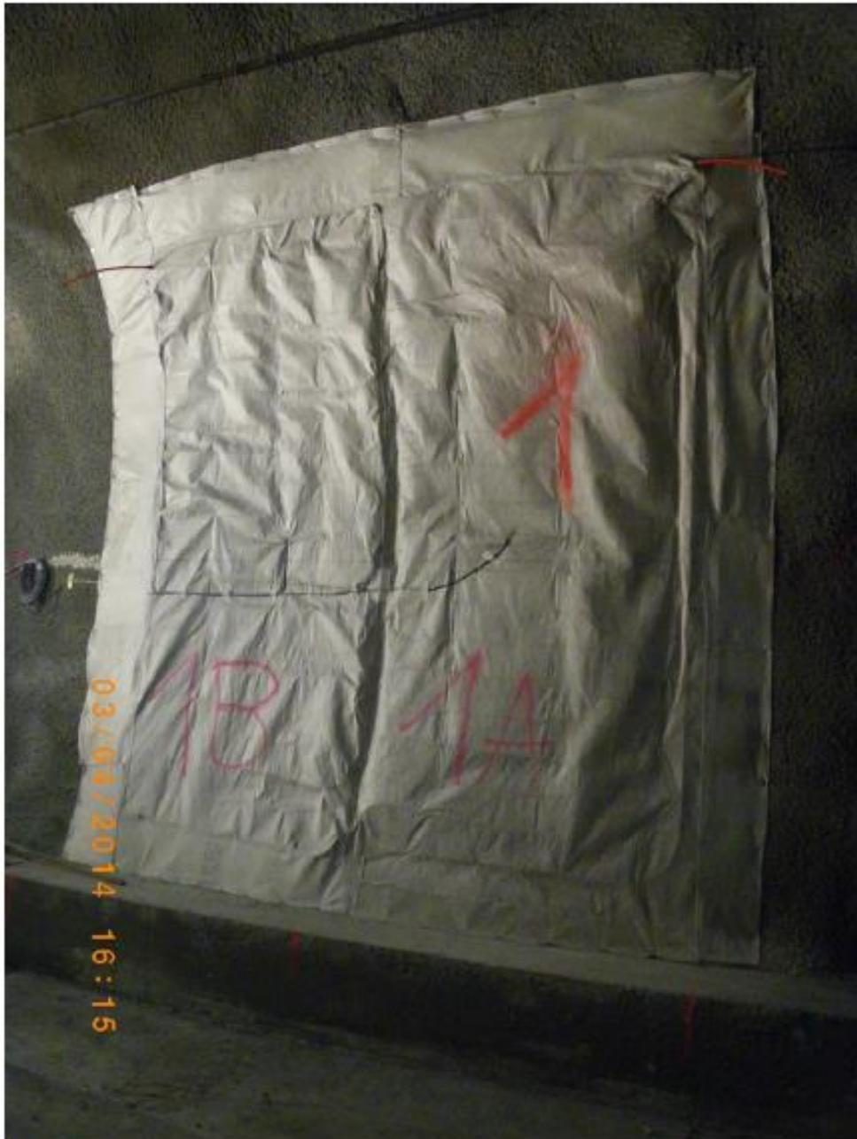
Abbildung 18 montiertes Absorbermodul, Abdichtung geschützt
