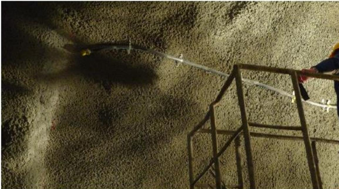
Abbildung 5 Versuchsfeld 2, Bewässerungsleitung
