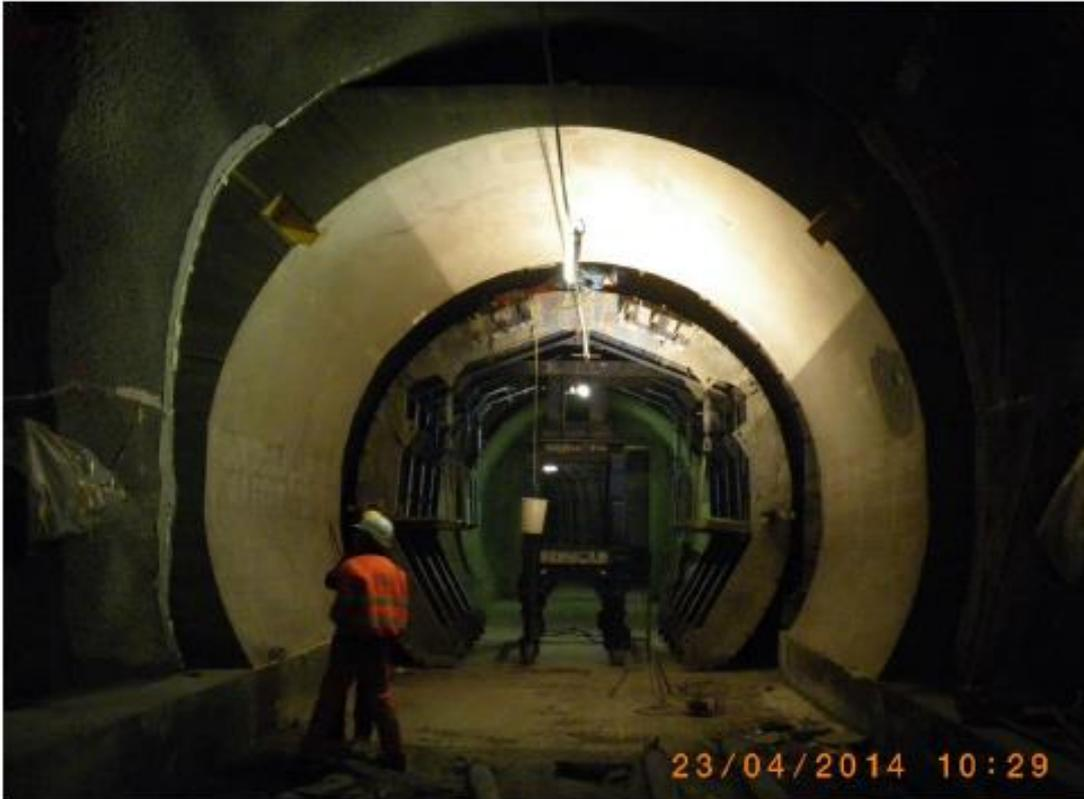
Abbildung 21 Betoninnenschale erstellt
