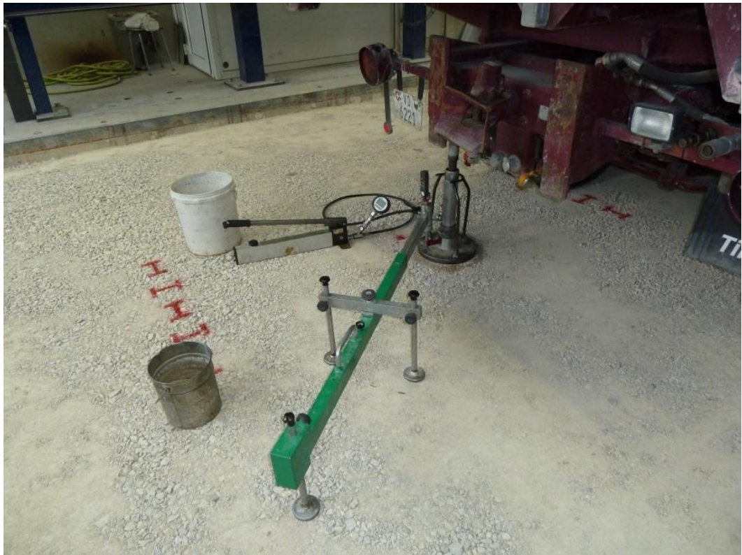
Fig. 24 Essai de plaque sur la grave de fondation.
