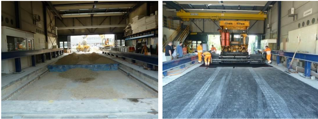
Fig. 16 Construction des structures de chaussées dans la halle fosse
