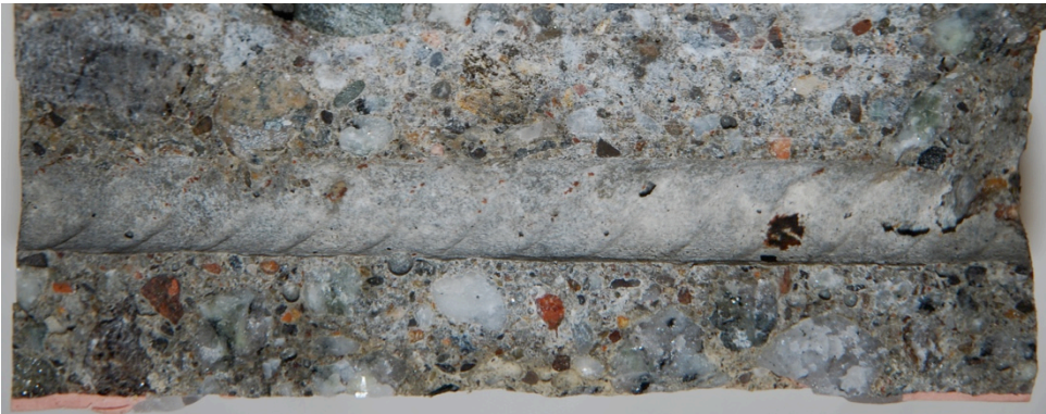
Abb. 29 Fotografische Dokumentation der Korrosionsstelle bei Prüfkörper G6 (dunkelbraune Korrosionsprodukte auf dem Beton nach Herauslösen des Bewehrungsstahls) (Chlorideintrag von unten). Initiiierung hinter einem grösseren Gesteinskorn in der Überdeckung. Visuelle Inhomogenitäten direkt an der Stahl/Beton-Grenzfläche waren jedoch keine ersichtlich.
