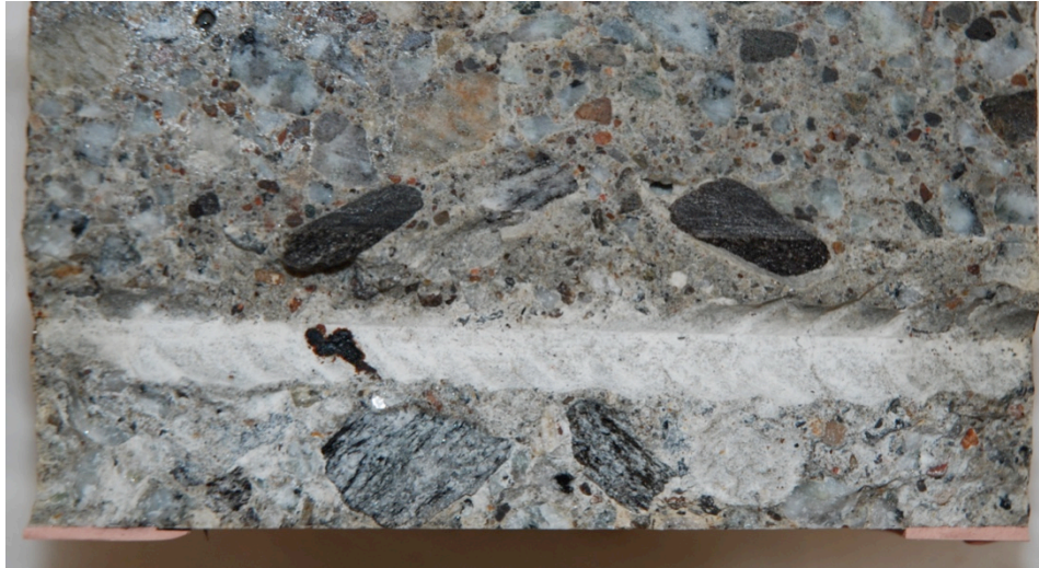
Abb. 24 Fotografische Dokumentation der Korrosionsstelle bei Prüfkörper G1 (dunkelbraune/schwarze Korrosionsprodukte auf dem Beton nach Herauslösen des Bewehrungsstahls) (Chlorideintrag von unten). Initiierung hinter einem grösseren Gesteinskorn in der Überdeckung. Visuelle Inhomogenitäten direkt an der Stahl/Beton-Grenzfläche waren jedoch keine ersichtlich.
