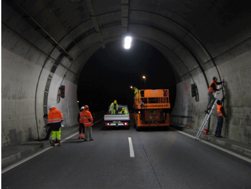
Abb. 8 Foto der Zustandserfassungsarbeiten beim Portal Süd des Stalvedro-Strassentunnels.
