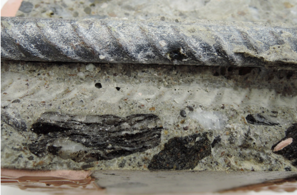
Abb. 36 Fotografische Dokumentation der Korrosionsstelle bei Prüfkörper Y7 (Chlorideintrag von unten). Schwarze Korrosionsprodukte auf dem Stahl sichtbar.
