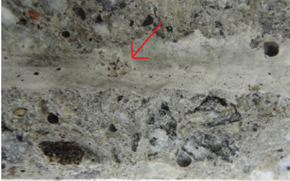
Abb. 26 Fotografische Dokumentation der Korrosionsstelle bei Prüfkörper Y2 (Chlorideintrag von unten). Nach Herauslösen des Bewehrungsstabes waren dunkelbraune Korrosionsprodukte am Beton haftend sichtbar. Im Bereich der Initiierungsstelle war der Beton direkt an der Stahl/Beton-Grenzfläche leicht poröser.
