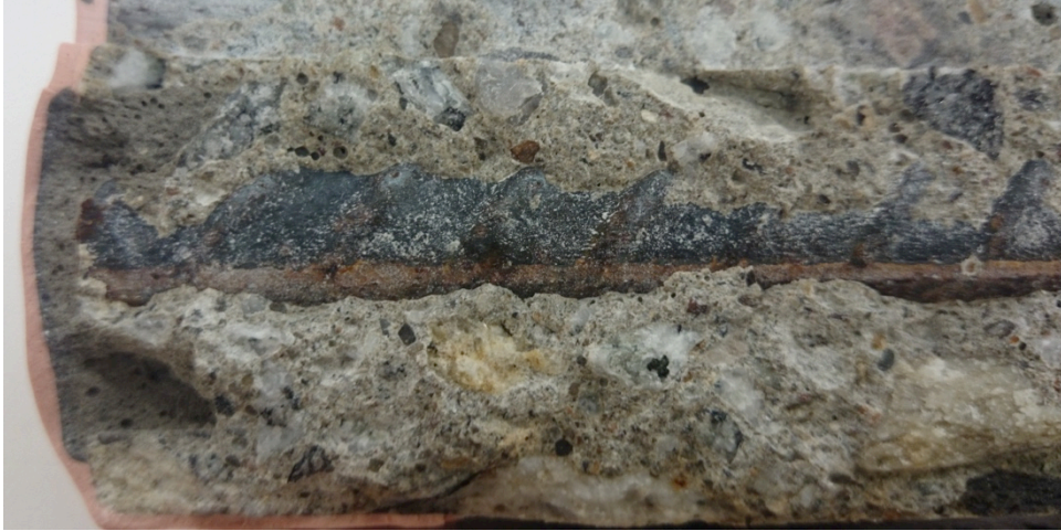
Abb. 38 Fotografische Dokumentation der Korrosionsstelle bei Prüfkörper G4 (Chlorideintrag von unten).
