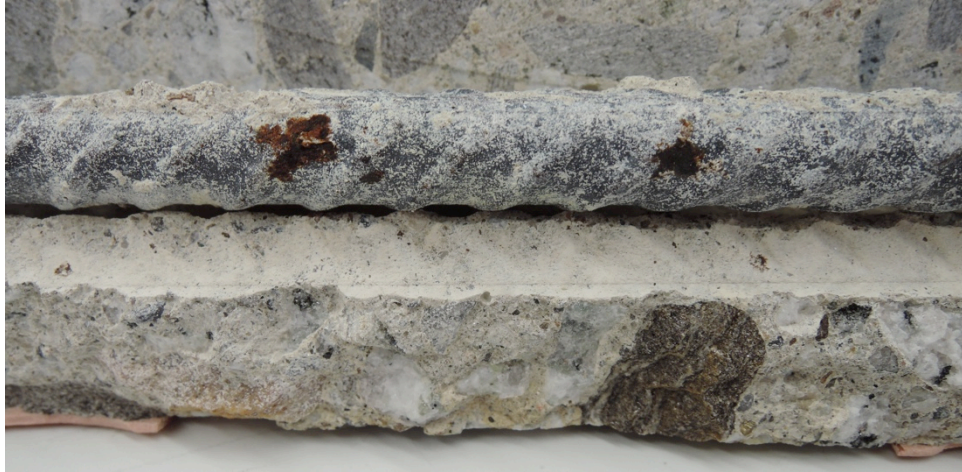
Abb. 30 Fotografische Dokumentation der Korrosionsstellen bei Prüfkörper G9 (dunkelbraune Korrosionsprodukte an zwei Stellen auf dem herausgelösten Bewehrungsstahl) (Chlorideintrag von unten). Rechts: Initiierung hinter einem grösseren Gesteinskorn in der Überdeckung. Visuelle Inhomogenitäten direkt an der Stahl/Beton-Grenzfläche waren jedoch in beiden Fällen keine ersichtlich.
