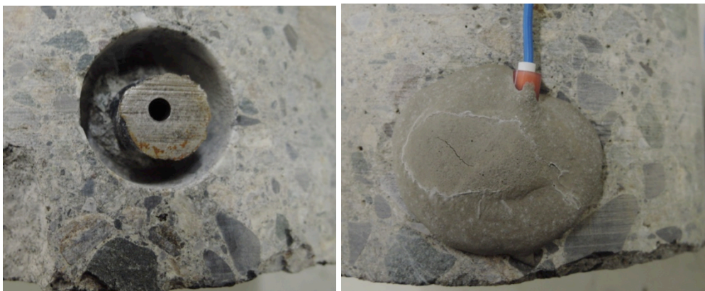
Abb. I3 Links: Freigelegtes Ende des Bewehrungsstabes sowie vorbereitetes Bohrloch für den elektrischen Anschluss mittels einer selbstschneidenden Blechschraube. Rechts: Nach dem Anschrauben des elektrischen Kabels und dem Schützen des Endbereiches der Bewehrung mit einem dichten Schutzmörtel.
