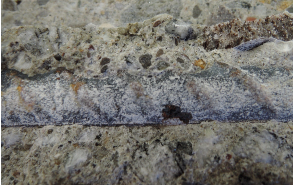
Abb. 34 Fotografische Dokumentation der Korrosionsstelle bei Prüfkörper Y4 (Chlorideintrag von unten). Dunkelbraune/schwarze Korrosionsprodukte.
