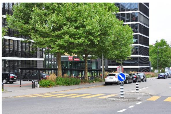
**Abb.14** Tempo-30-Zone mit baulichen und betrieblichen Elementen, die zum Erscheinungsbild einer übergeordneten (verkehrsorientierten) Strasse gehören (Mittelmarkierung, Fussgänger-Schutzinsel, Fussgängerstreifen)
