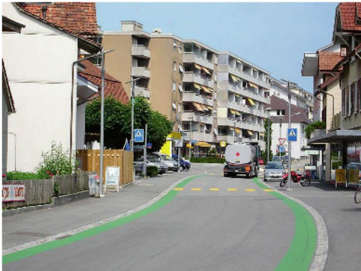
**Abb.22** Breite Bänder an Fahrbahnrad (Quelle: VSS Norm 640 214)
