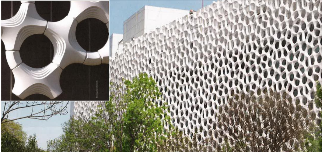
Abb. 7 Photokatalytisch aktive Fassade des „Hospital General Manuel Gea González“ in Mexico City, zusammengesetzt aus \text{TiO}_2 -beschichteten Kunststoffelemente in nur zwei unterschiedlichen Formen (kleines Bild; Staub, 2015 [37]).
