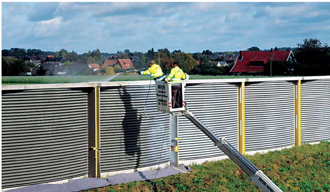
Abb. 9 Beschichtung einer Lärmschutzwand entlang der Autobahn A1 bei Osnabrück (Deutschland) mit einer photokatalytischen Suspension im Rahmen eines Pilotprojekts (BASt, 2012 [40]).
