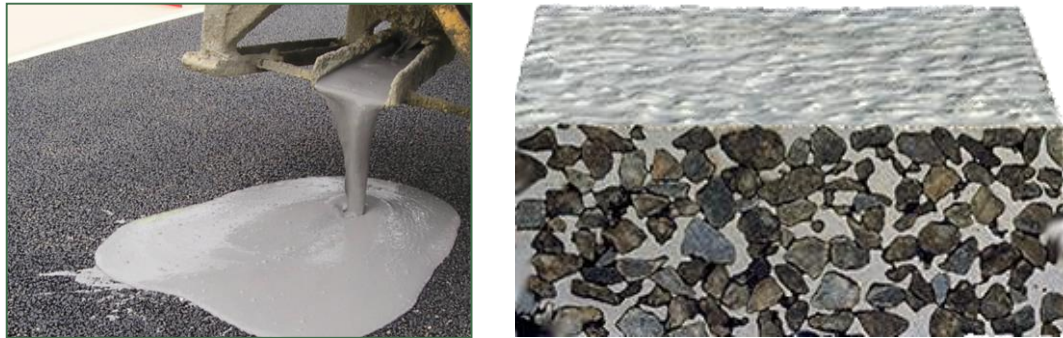
Abb. 13 Photokatalytischer Strassenbelag aus \text{TiO}_2 -haltigem Zement-Mörtel (hellgrau) und offenporigem Asphalt (dunkelgrau/schwarz). Links: Aufbringung des flüssigen Mörtels auf die Asphaltdecke. Rechts: Schnittansicht des fertigen Asphalt-Mörtel-Belags. (Crispino, 2014 [25]).
