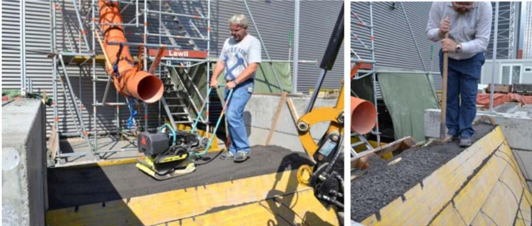
**Abb. 4.6** Verdichtung des Dammmaterials DBS 2, Planiekies 0/25, mit Rüttelplatte und händisch im Kronenbereich.
