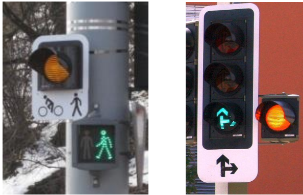
Abb. 8 Gelbblinken als Warnzeichen für die abbiegenden Autofahrer. Links: Route de Chancy, Genf: Konfliktschaltung nach rechts. (Quelle: Büro für Mobilität AG) Rechts: Konfliktschaltung nach auf der Schaffhauserstrasse in Bülach (ZH) (Quelle: Rapp Trans AG)
