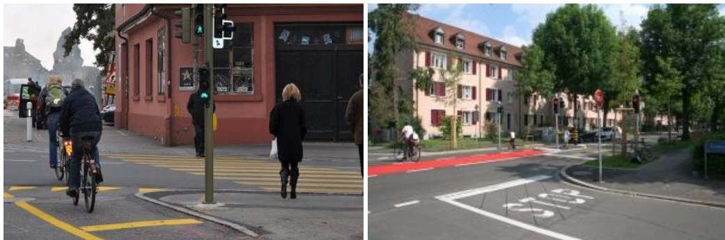
Abb. 29 Links: Kleines Velolichtsignal mit verbesserter Anmeldevorrichtung in Biel, Marcellin-Chipot-Strasse / Aarbergstrasse (Quelle: www.pro-velo-biel.ch ) Rechts: Anmeldevorrichtung in Basel, Ecke Morgartenring / Gottfried-Keller-Strasse. Anforderung der Grünphase auf dem roten Belag.
