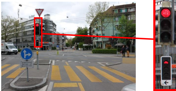
Abb. 22 Kreuzung in Bern (Breitenrainstrasse / Nordring) – Direktes Linksabbiegen mit Abbiegespur in Fahrbahnmitte. Der MIV darf an dieser Kreuzung nicht nach links abbiegen (Quelle: Kanton Bern)
