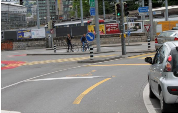
Abb. 23 Neubrückstrasse / Tiefenaustrasse in Bern: Ein ausgeweiteter Radstreifen ist ein sicherer Wartebereich für die nach links abbiegenden Velofahrer. Ein zuführender Velostreifen muss vorhanden sein (Quelle: Kanton Bern)
