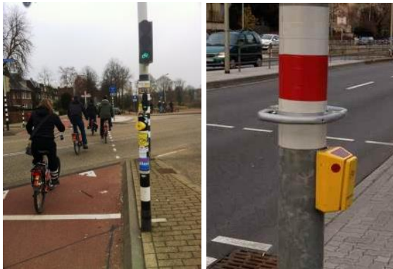
Abb. 31 Links: Ampelgriff in Nijmegen, Holland (Quelle: Büro für Mobilität AG), Rechts: Karlsruhe (mit Rundgriff) (Quelle: Amt für Mobilität BS)
