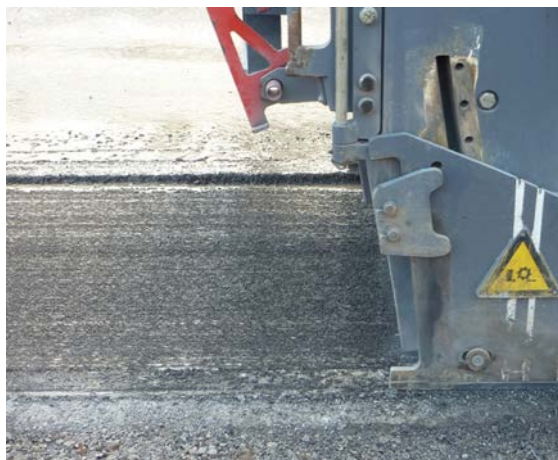
Abb. 19 Fräsen der Deckschicht
