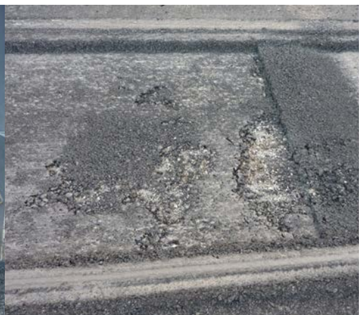
Abb. 20 Fräsen der Tragschicht mit Stellen wo der Koffer angefräst wurde
