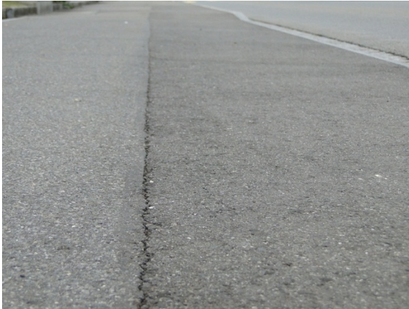
Abb. I.13 Anschlussfuge mit Plastmasse.
