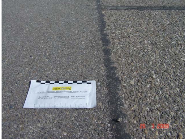
Abb. I.1 Anschlussfuge mit selbstklebendem Fugenband.
