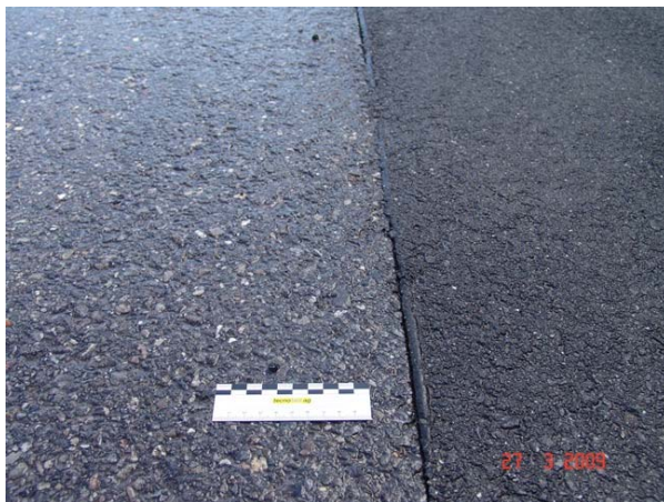
Abb. I.2 Anschlussfuge mit selbstklebendem Fugenband.
