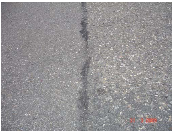
Abb. I.18 Anschlussfuge mit Plastmasse.
