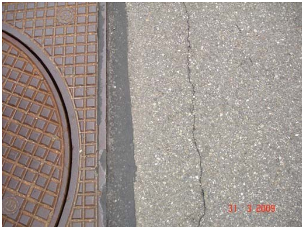
Abb. I.34 Anschlussfuge „Asphalt - Stahl“.
