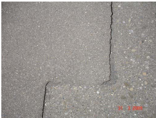
Abb. I.9 Anschlussfuge mit angeflämmten Fugenband.
