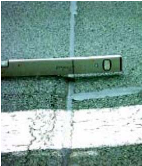
Abb. 4.29 Nicht vorhandene Längsebenheit an der Quernaht (Bild aus [13])
