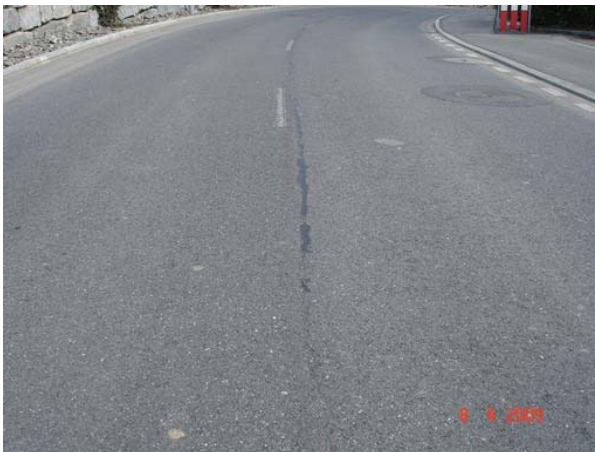
Abb. I.15 Anschlussfuge mit Plastmasse.
