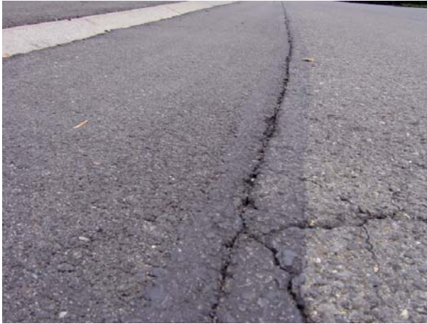
Abb. I.24 Anschlussfuge „keine Massnahme“.
