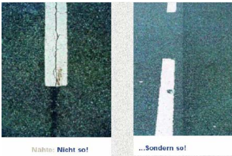
Abb. 4.35 Einplanen der Fahrbahnränder (Bild aus [13])
