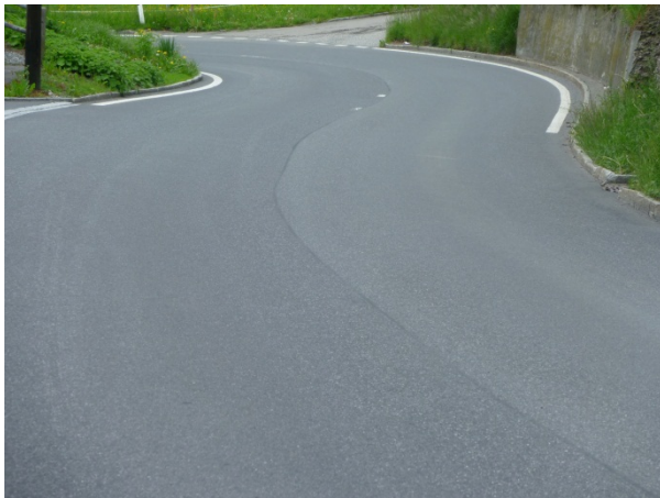
Abb. I.10 Anschlussfuge mit heiss extrudiertem Fugenband.
