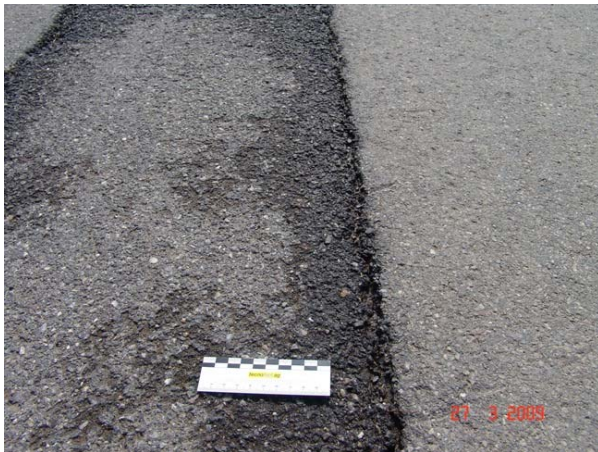
Abb. I.22 Anschlussfuge „keine Massnahme“.
