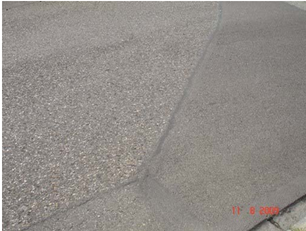
Abb. I.16 Anschlussfuge mit Plastmasse.
