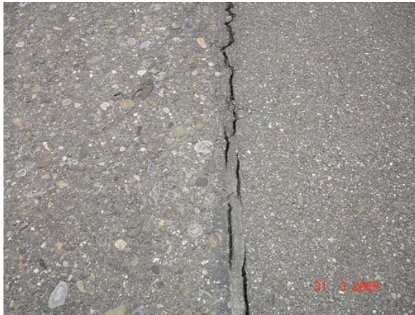
Abb. I.8 Anschlussfuge mit angeflämmten Fugenband.
