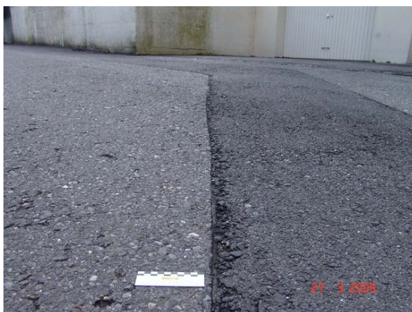
Abb. I.3 Anschlussfuge mit selbstklebendem Fugenband.
