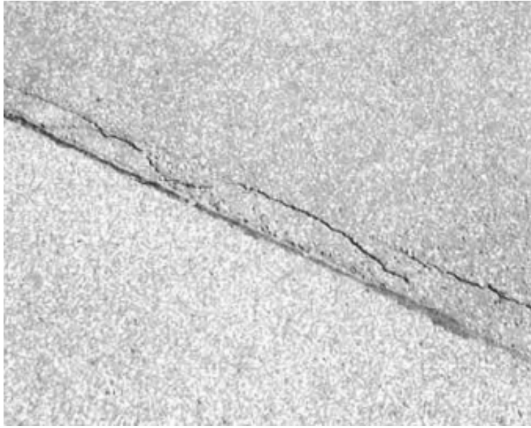
Abb. 4.38 Wird nur die Deckschicht abgetrepppt, besteht die Gefahr eines Reflexionsrisses in der Verlängerung der Grabenwand [7].
