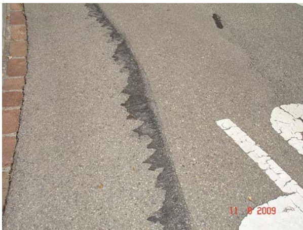
Abb. I.17 Anschlussfuge mit Plastmasse.
