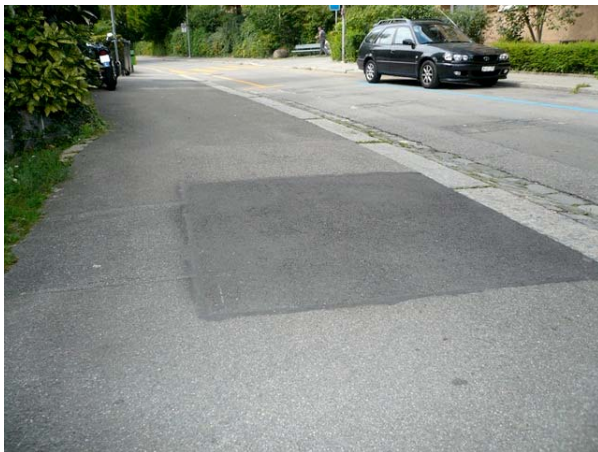
Abb. 1.6 Anschlussfuge mit selbstklebendem Fugenband.
