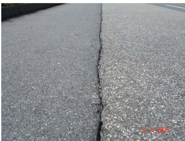
Abb. I.23 Anschlussfuge „keine Massnahme“.
