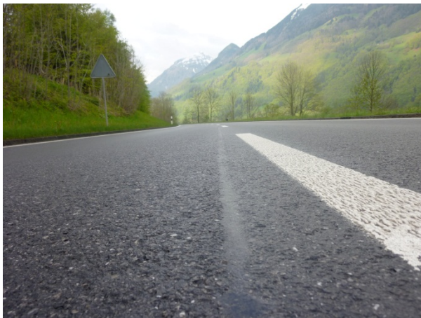
Abb. I.11 Anschlussfuge mit heiss extrudiertem Fugenband.
