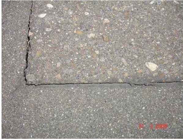
Abb. I.7 Anschlussfuge mit angeflämmten Fugenband.
