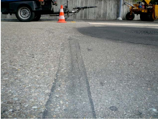
Abb. I.19 Anschlussfuge mit Plastmasse.
