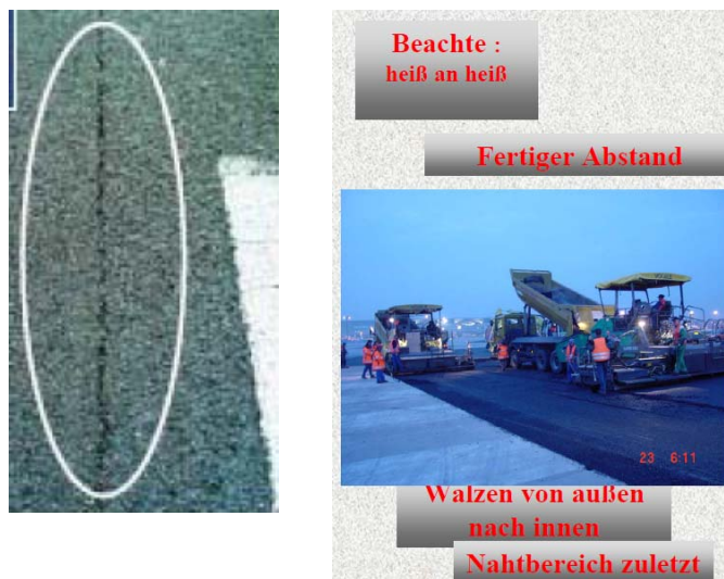
Abb. 4.27 Offene Längsnaht (heiss an heiss) und Walzenregime (Bilder aus [13]).
