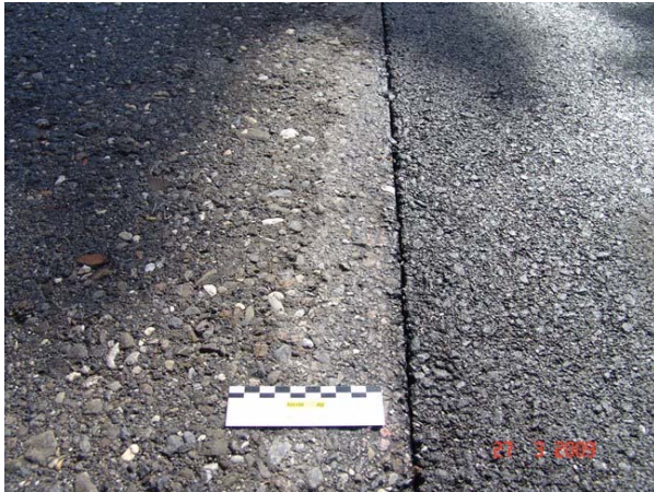
Abb. I.21 Anschlussfuge „keine Massnahme“.
