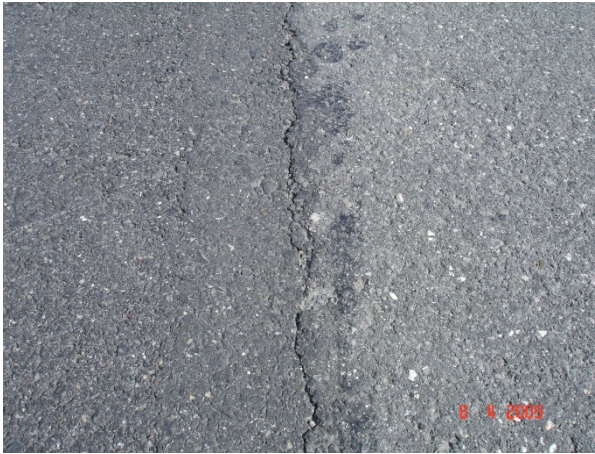
Abb. I.14 Anschlussfuge mit Plastmasse.
