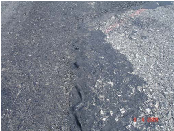
Abb. I.20 Anschlussfuge mit Fugenmasseanstrich.
