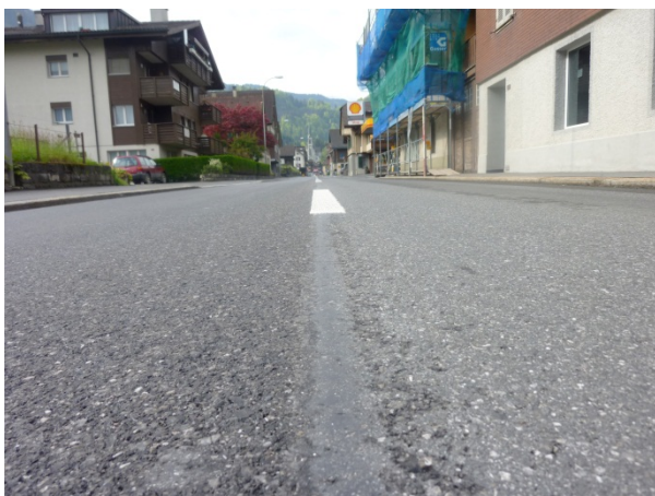
Abb. I.12 Anschlussfuge mit heiss extrudiertem Fugenband.
