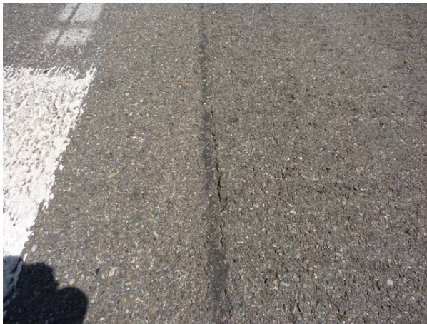
Abb. 1.5 Anschlussfuge mit selbstklebendem Fugenband.
