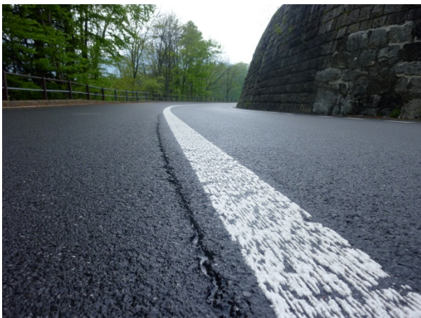
Abb. I.26 Anschlussfuge „keine Massnahme“.
