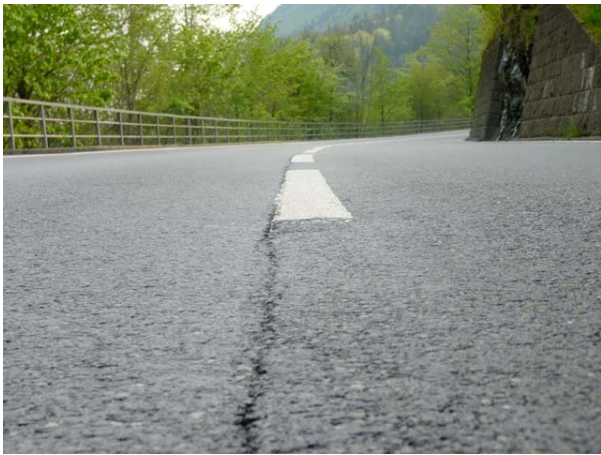
Abb. I.25 Anschlussfuge „keine Massnahme“.
