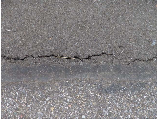
Abb. 1.4 Anschlussfuge mit selbstklebendem Fugenband.
