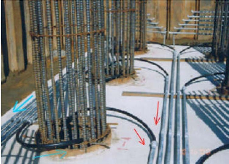
Figure 2-13 Pieux énergétiques en culée de pont, pont de Shin-Kiyonaga, Fukui, Japon [23].
