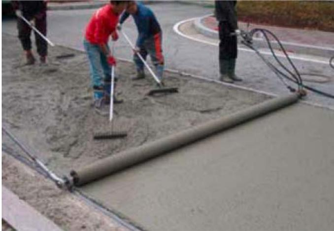
Figure 2-6 Mise en place du béton renforcé de fibres d'acier [18].
