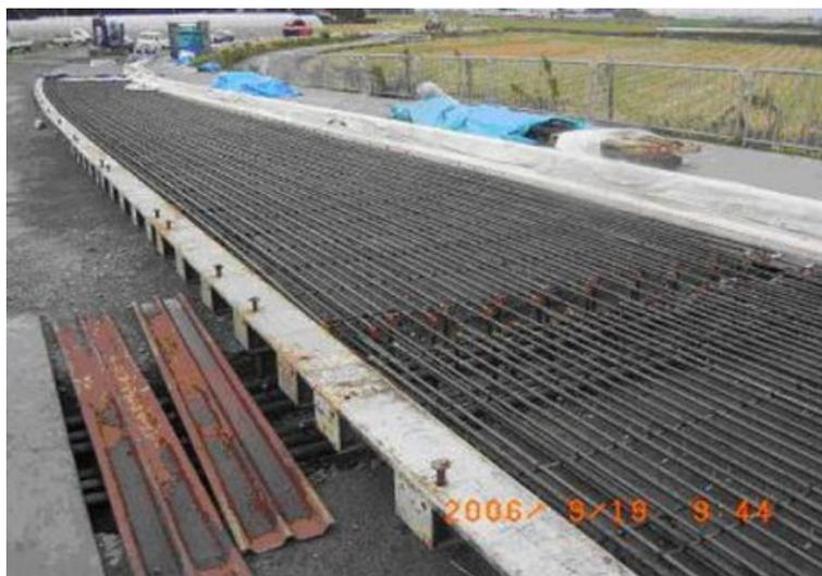
Figure 2-12 Vue du dispositif de chauffage sur la rampe d'accès au pont de Shin-Kiyonaga, Fukui, Japon [22].
