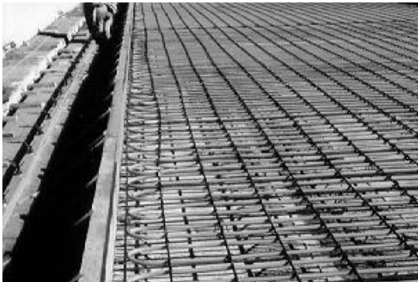
Figure 2-8 Vue de l'échangeur de chaleur en tablier avant coulage de la chaussée en béton [19].
