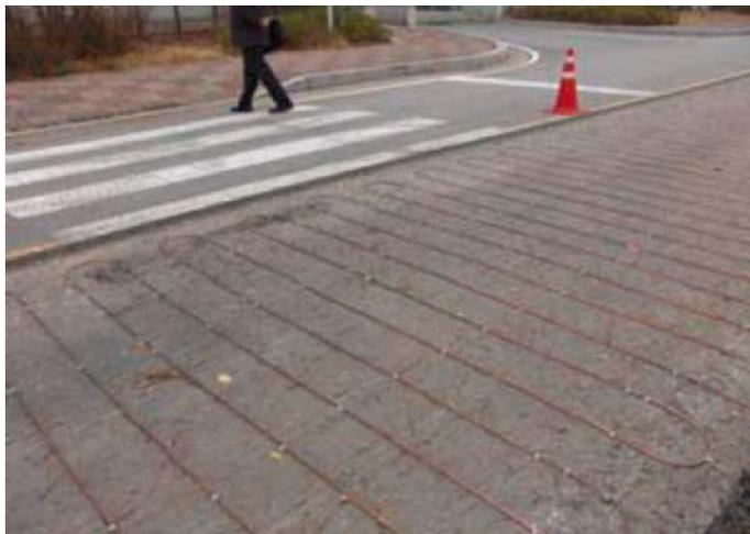
Figure 2-5 Tuyaux en cuivre dans l'épaisseur de la chaussée [18].
