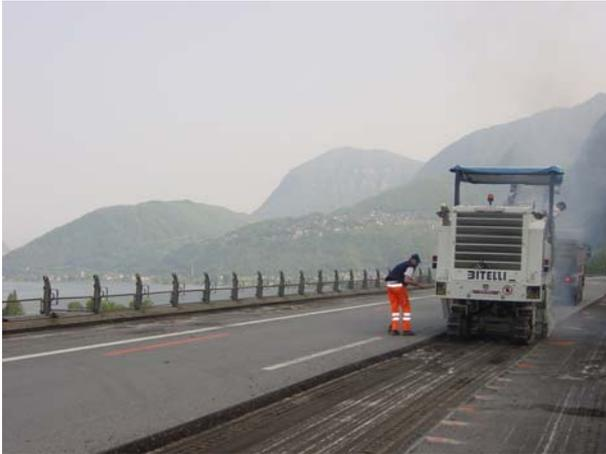
*Abbildung 1.1.7: Abfräsen des Belages auf dem Objekt 3*
