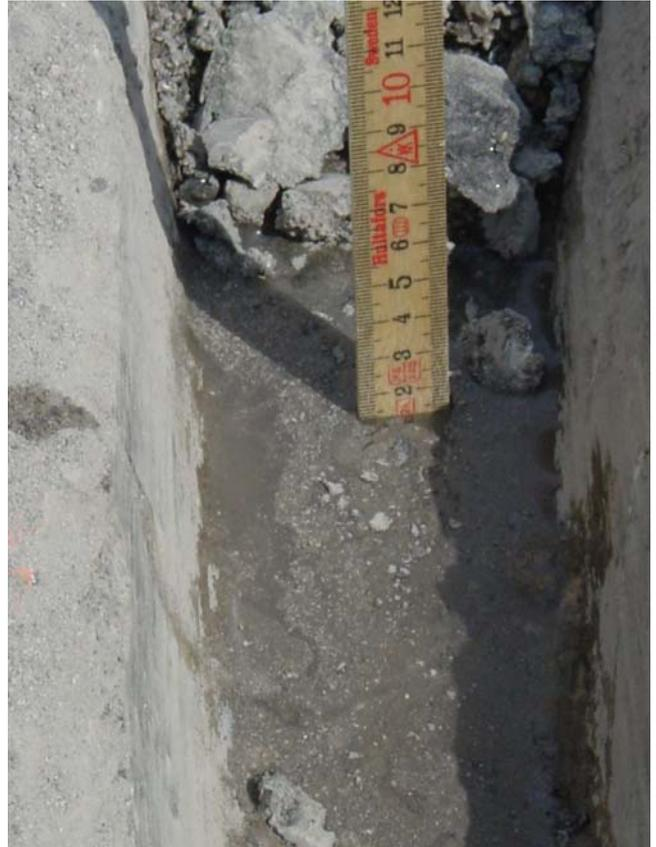
Abbildung 10.2.16: Wasser im Belagsschlitz
