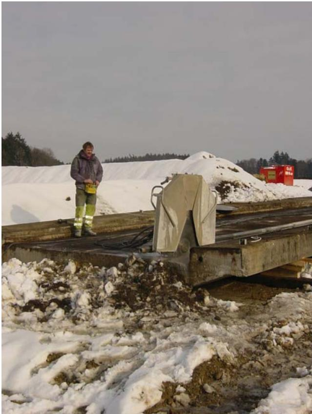
*Abbildung 10.4.10: Schneiden der Brückenplatte*
