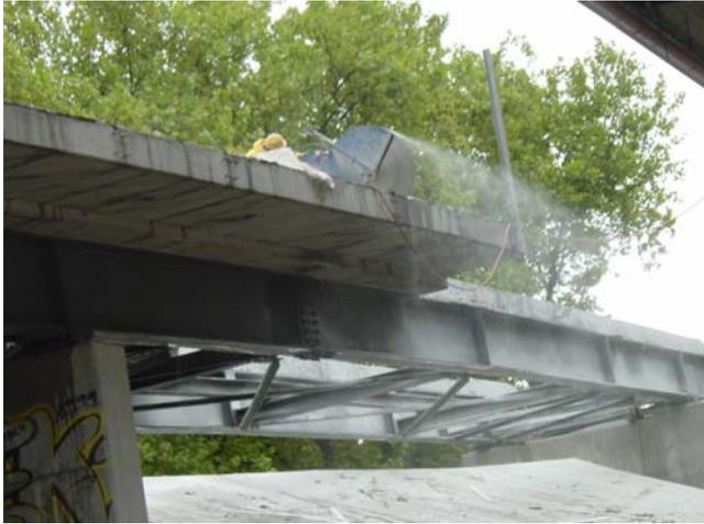
Abbildung 10.2.19: Betonabbruch
