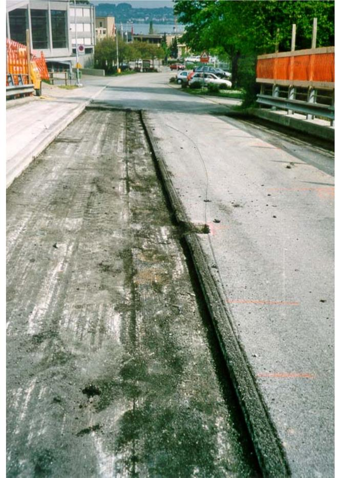
Abbildung 10.1.11: Fräskante, Spur Mitte, S2
