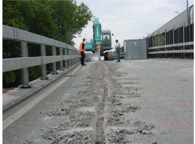
*Abbildung 1.1.8: Belagsöffnung mittels Baggerzahn auf Objekt 2*
