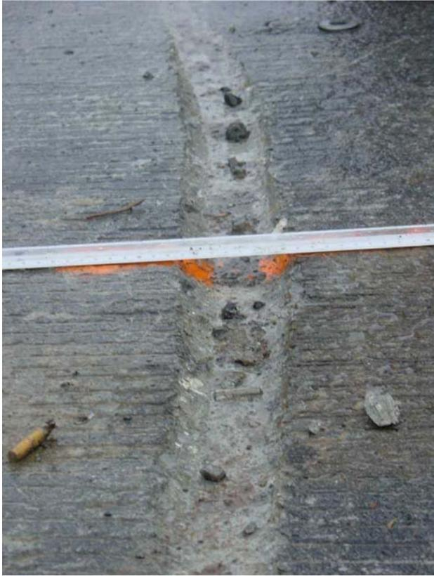
Abbildung 10.2.15: durch Baggerzahn abgetragener Beton
