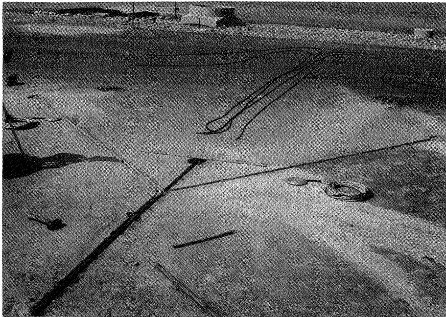
Abbildung 9: Installation der Druckmessdosen;
